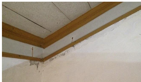
Figura 30 Perda da Camada de Reboco. Fonte: Thatiane Rocha 2017
