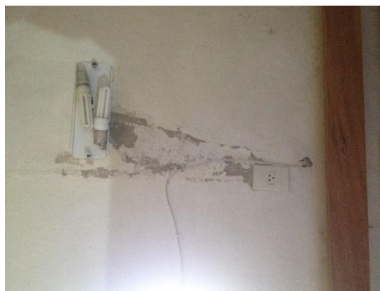
Figura 39 Fiação Exposta
