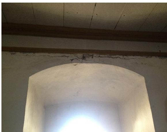
Figura 31 Trincas. Fonte: Thatiane Rocha 2017
