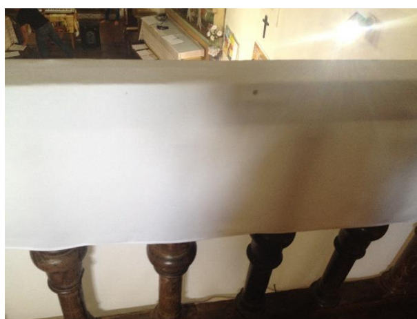
Figura 33 Detalhe da Balastrada.
