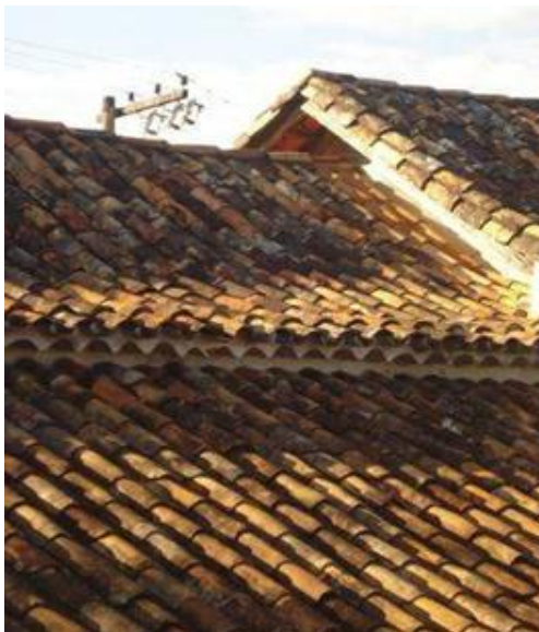
Figura 38 Detalhe do Caimento das águas do Telhado.
