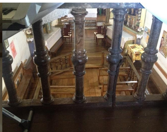
Figura 32 Balastrada com Partes Faltantes. Fonte: Thatiane Rocha 2017
