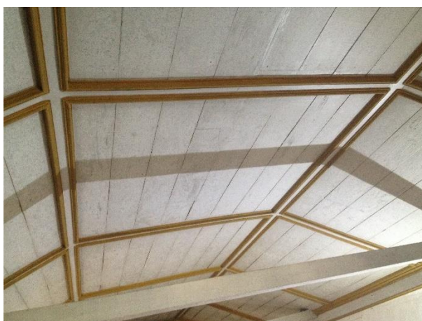
Figura 37 Detalhe do Forro. Fonte: Thatiane Rocha 2017
