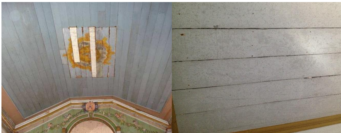
Figura 35 Partes Faltantes do Forro. Fonte: Thatiane Rocha 2017
