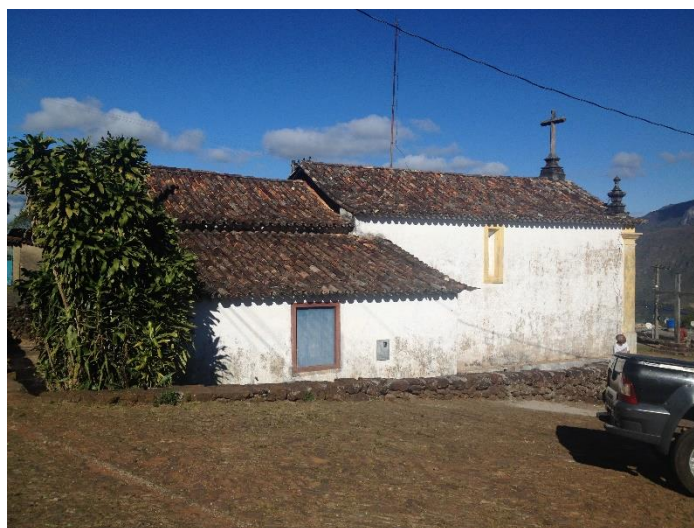
Figura 25 Vista Parcial do Telhado.
