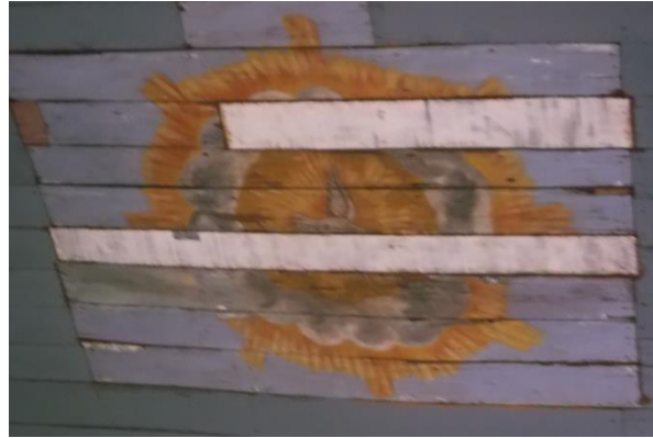
Figura 6 Complementação das partes faltantes do forro. Fonte: Natália Rodrigues 2017
