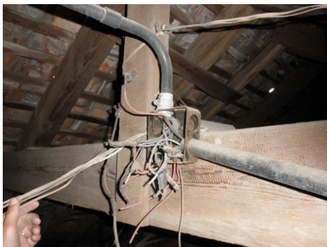
Figura 03: Fios desorganizados nas caixas :
