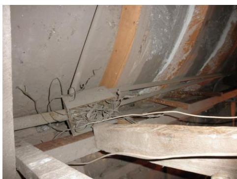
Figura 03: Fios desorganizados nas caixas :
