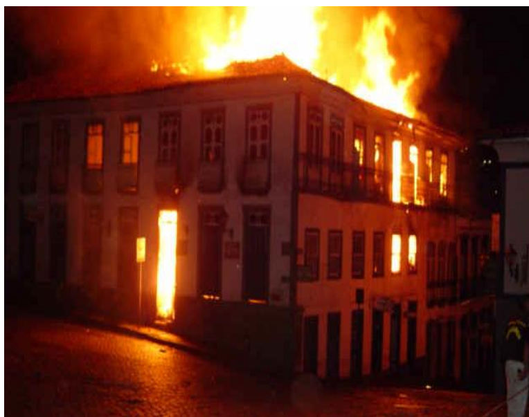
Figura 06: incêndio do hotel pilão em Ouro Preto
