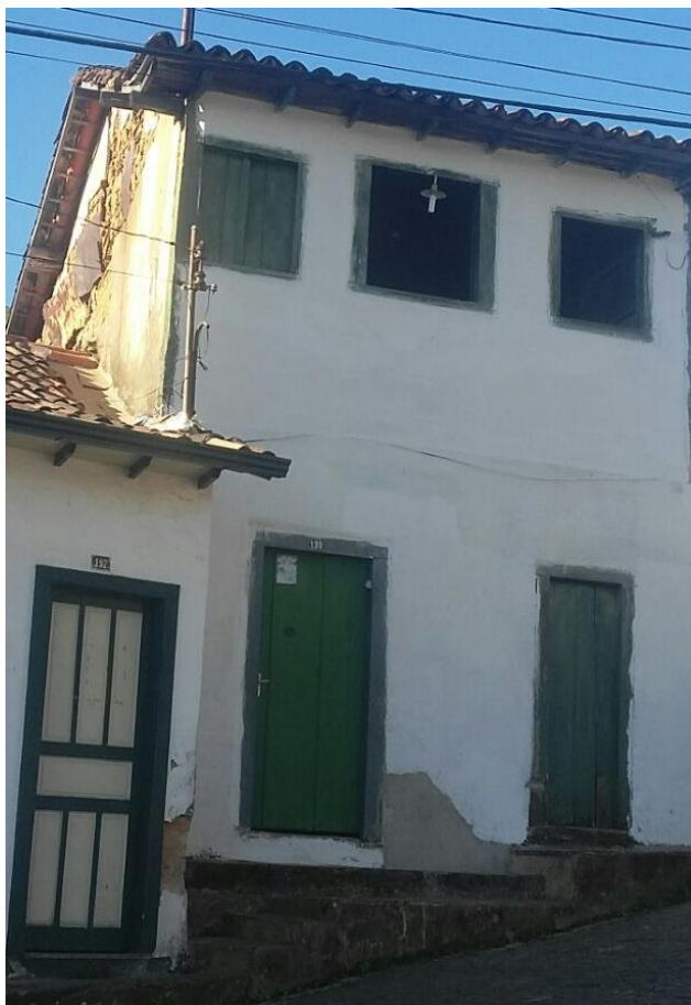
Figura 16: Casa situada na Rua Santa Efigênia, bairro Antônio Dias. FONTE: Acervo autora, 2017.
