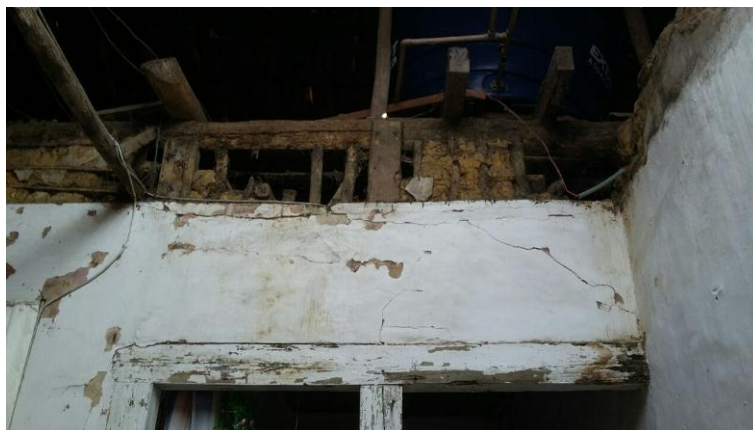
FIGURA 15: Vista da cozinha sem o forro. Fonte: ACERVO AUTORA, 2017.
