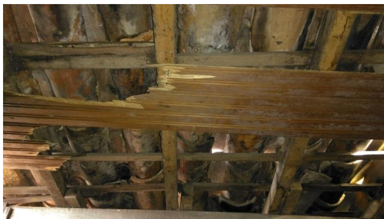
Figura 8: Resquícios do forro em madeira no segundo pavimento. FONTE: Acervo autora, 2017.
