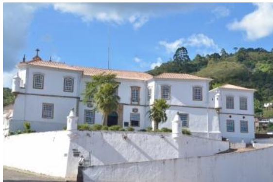
FIGURA 24 - Palácio dos Governadores, Ouro Preto. Atual Museu da Escola de Minas. Fonte: Portal do Turismo, 2015. 11
