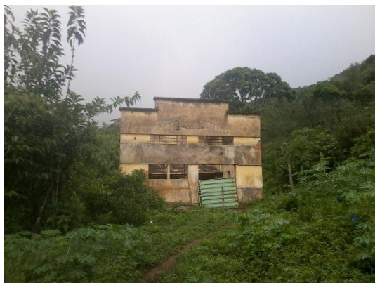
FIGURA 28 – Antigo Matadouro Municipal na região do Passa Dez. Fonte: PIBIC/IFMG-OP, 2015
