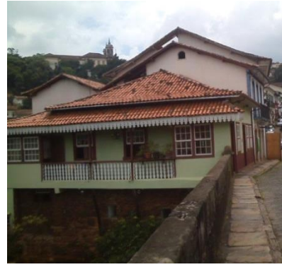
Fig.22- Detalhe de edificação com tipologia de cobertura de quatro águas Autoria: Roberta Silva Data: Fevereiro/ 2016
