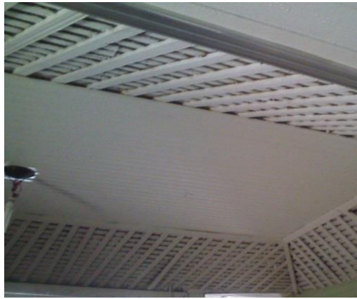
Fig.92-Forro treliça no palco do pavimento superior
