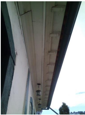
Fig.73- Detalhe do acabamento da cobertura Autoria: Roberta Silva Data: Março 2016
