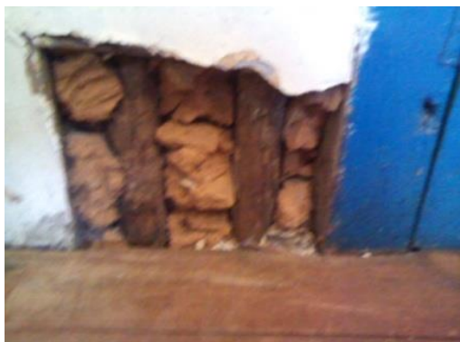
Fig.66-Detalhe da estrutura em pau- a –pique exposta no escritório primeiro pavimento Autoria: Roberta Silva Data: Março 2016
