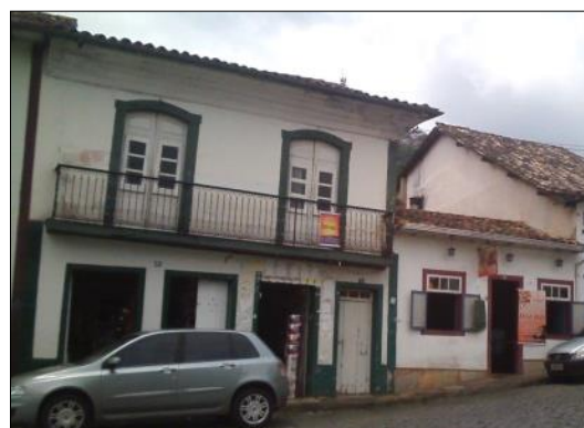
Fig.31. Edificações de uso misto residencial /comercial e uso comercial Autoria: Roberta Silva Data: Fevereiro/ 2016
