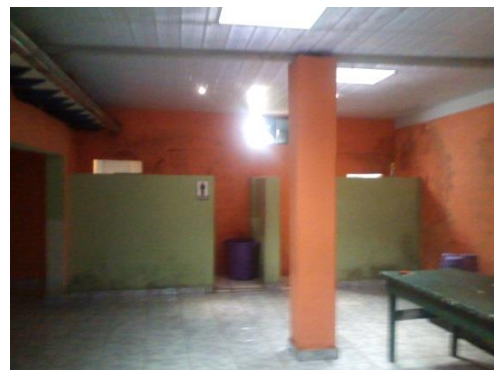
Fig. 65-Viga de sustentação em alvenaria de tijolo Autoria: Roberta Silva Data: Março 2016
