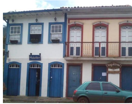
Fig. 25. Edificação de dois pavimentos Autoria: Roberta Silva Data: Fevereiro/ 2016
