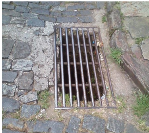
Fig.40 Detalhe da drenagem pluvial Autoria: Roberta Silva Data: Fevereiro/ 2016
