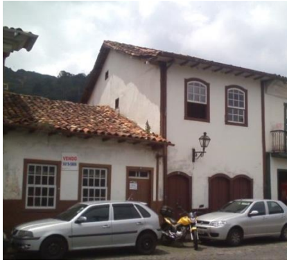
Fig.21- Detalhe de edificação com tipologia de cobertura de duas águas Autoria: Roberta Silva Data: Fevereiro/ 2016
