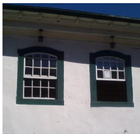
Fig.69-Janelas tipo guilhotina com enquadramento em madeira fachada frontal. Autoria: Roberta Silva Data: Março 2016
