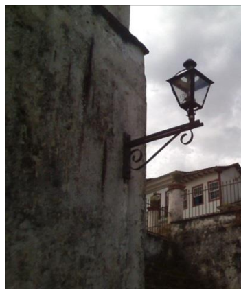
Fig.45- Detalhe da iluminação indireta Autoria: Roberta Silva Data: Fevereiro/ 2016
