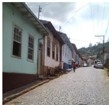
Fig.2. Detalhe das edificações erguidas em formato retangular no nível da rua Autoria: Roberta Silva
