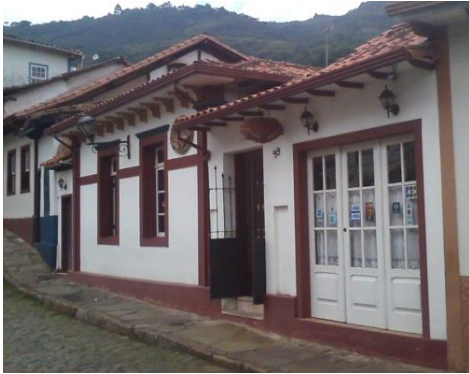
Fig. 24. Edificação de um pavimento Autoria: Roberta Silva Data: Fevereiro/ 2016
