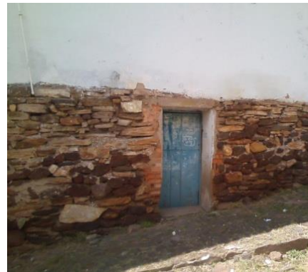
Fig.81-Estrutura em pedra, exposta. Fonte: Roberta Silva Data: Março 2016
