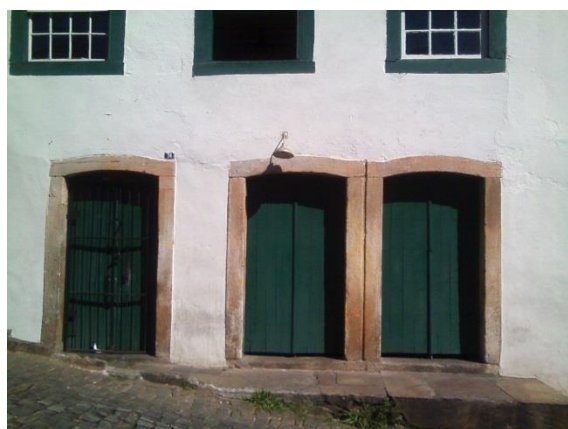
Fig.68-Enquadramento das portas em alvenaria de pedra. Autoria: Roberta Silva Data: Março 2016
