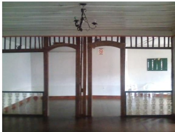
Fig.93- Estrutura de madeira aparente, entre os salões 02 e 03, pavimento superior.
