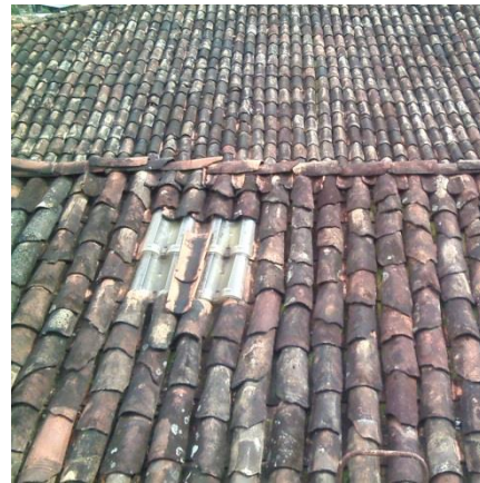
Fig.74- Telhas transparentes permite a passagem da luz natural. Autoria: Roberta Silva Data: Março 2016
