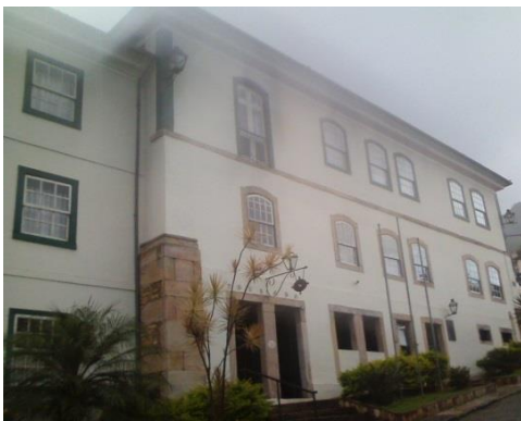
Fig. 26. Edificação de três pavimentos Autoria: Roberta Silva Data: Fevereiro/ 2016
