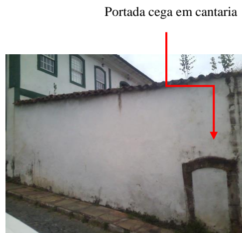
Fig.79-Muro na extensão da fachada lateral esquerda Fonte: Roberta Silva Data: Março 2016
