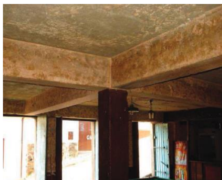
Fig.90-Forro em laje de concreto, cômodo 01 pavimento inferior. Autoria: Roberta Silva Data: Março 2016
