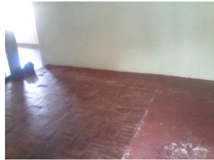
Fig.83-Piso em taco e cimento queimado, palco pavimento superior. Autoria: Roberta Silva Data: Março 2016
