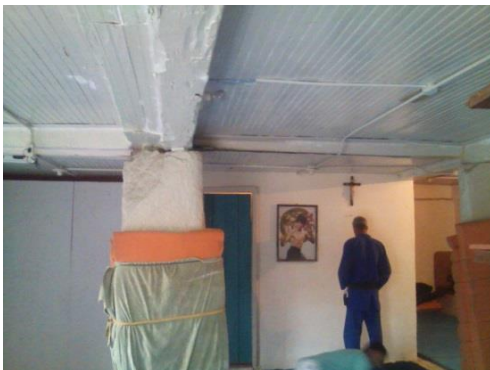
Fig. 64-Viga de sustentação em alvenaria de pedra Autoria: Roberta Silva Data: Março 2016
