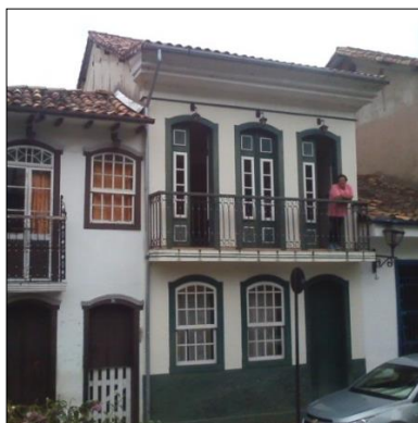
Fig.30. Edificações de uso residencial Autoria: Roberta Silva Data: Fevereiro/ 2016
