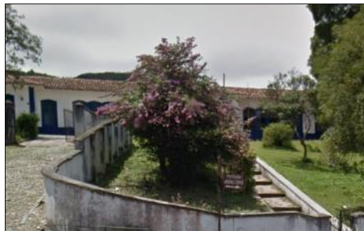
Fig.34. Edificação de uso institucional – Escola Estadual Marília de Dirceu Autoria: Roberta Silva Data: Fevereiro/ 2016
