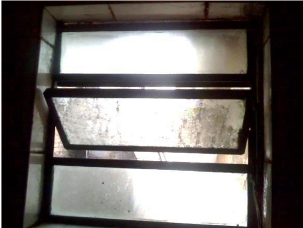
Fig.70-Basculante de metal com vidro Fonte: Roberta Silva Data: Março 2016
