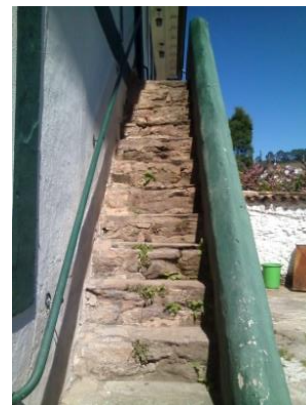
Fig.77-Escadaria de acesso ao primeiro pavimento Autoria: Roberta Silva Data: Março 2016
