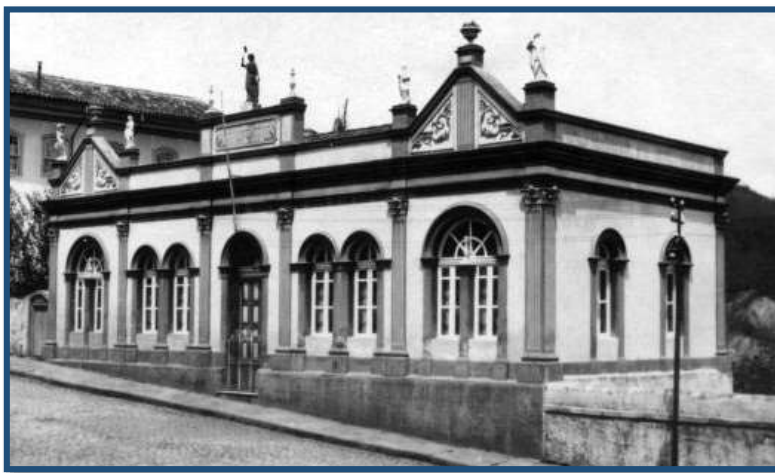
Figura 51: Edificação que hoje abriga o Cine Vila Rica aproximadamente no ano de 1925. Praça Reinaldo Alves de Brito. Ouro Preto.
