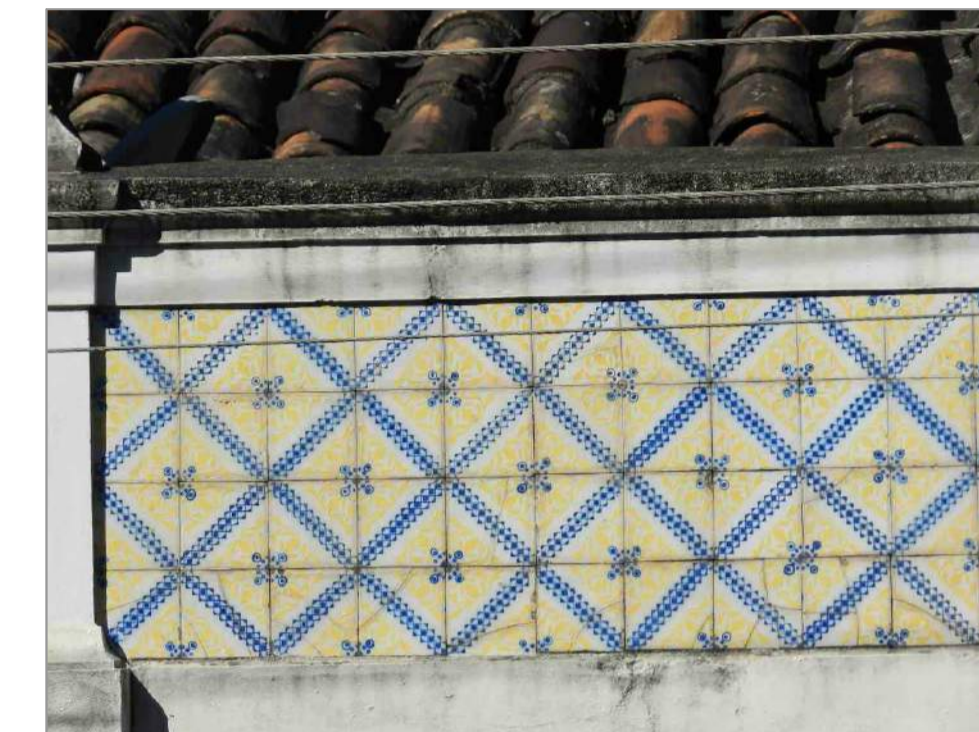
Extremidade direita do painel 18.
