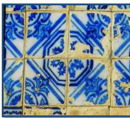
Figura 77: Azulejos com perda de vidrado pelas arestas. Fonte: Marina Poloni, 2015.
