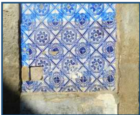
Figura 72: Trecho do painel azulejar entre duas portas, com recomposição de material.
