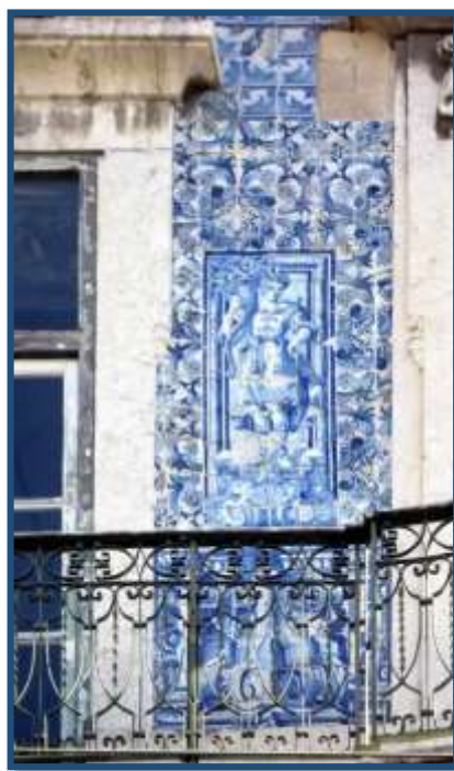
Figura 17: Ocorrência de painéis figurados com azulejos de tapete na fachada da Cervejaria Trindade.
