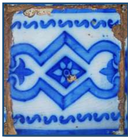
Figura 75: Azulejo com fissuração. Fonte: Marina Poloni, 2015.
