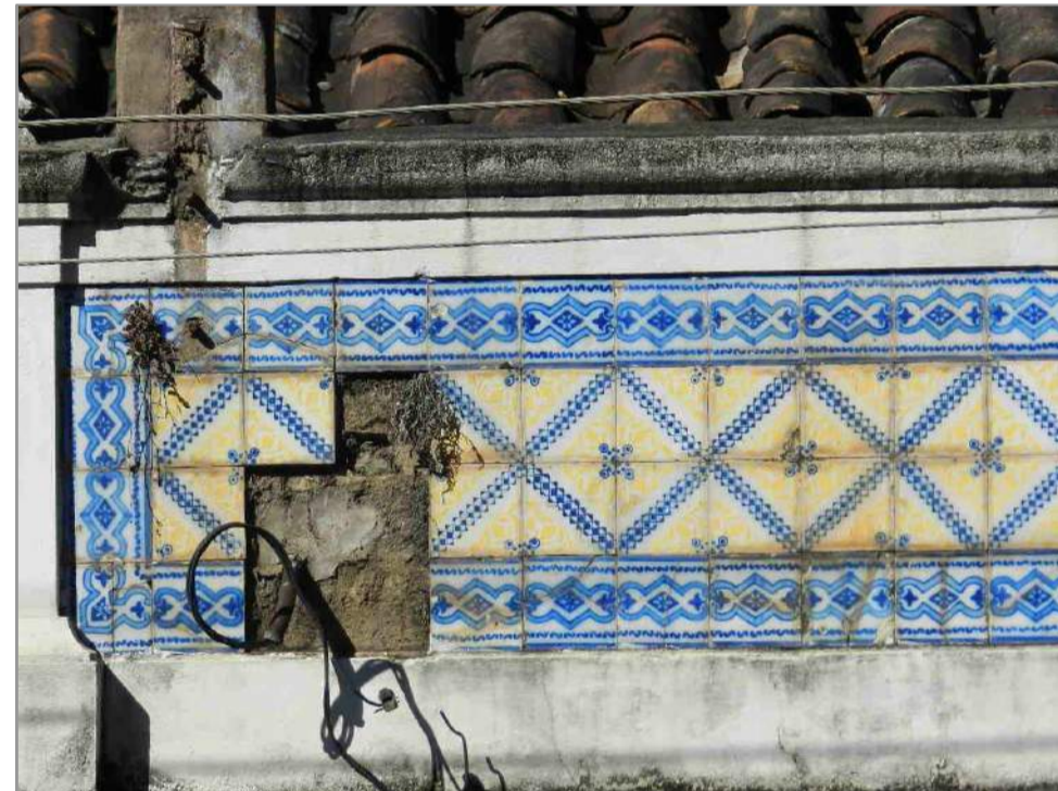
Extremidade direita do painel 19.
