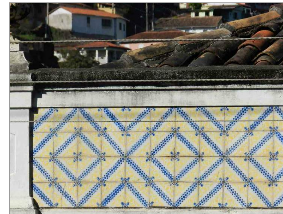
Extremidade direita do painel 17.
