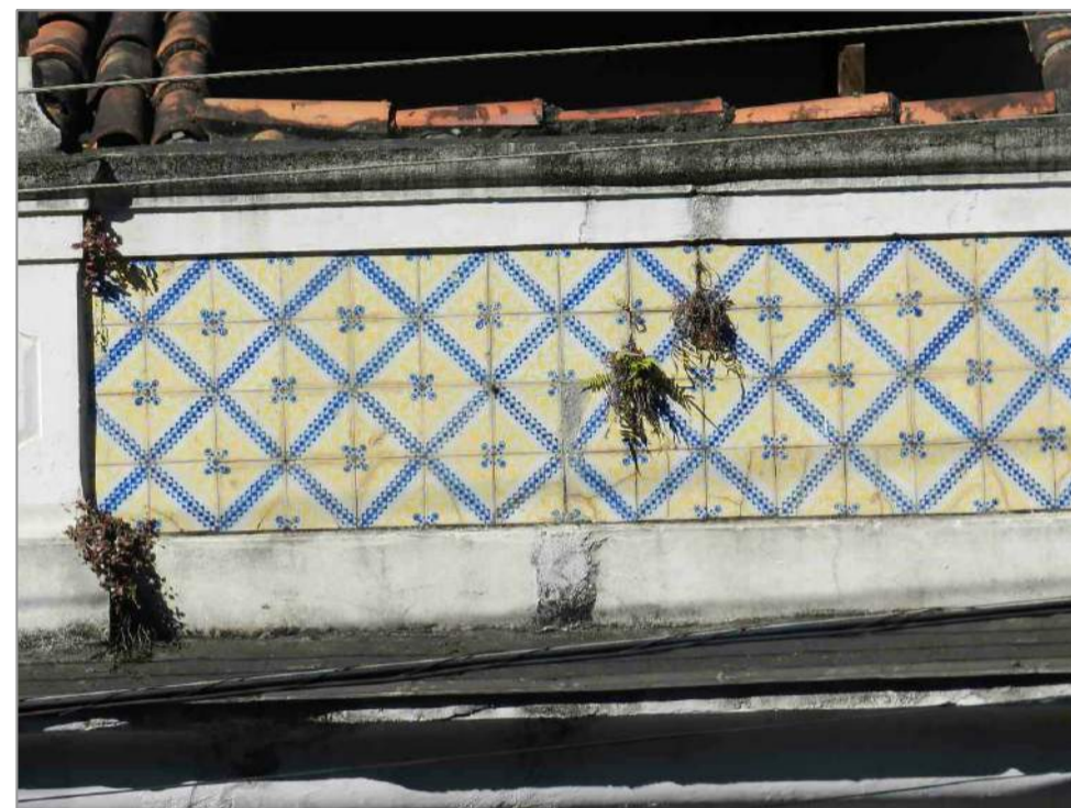
Extremidade direita do painel 20.
