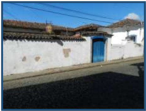
Figura 28: Vista externa do muro que delimita o quintal do edifício anexo.
