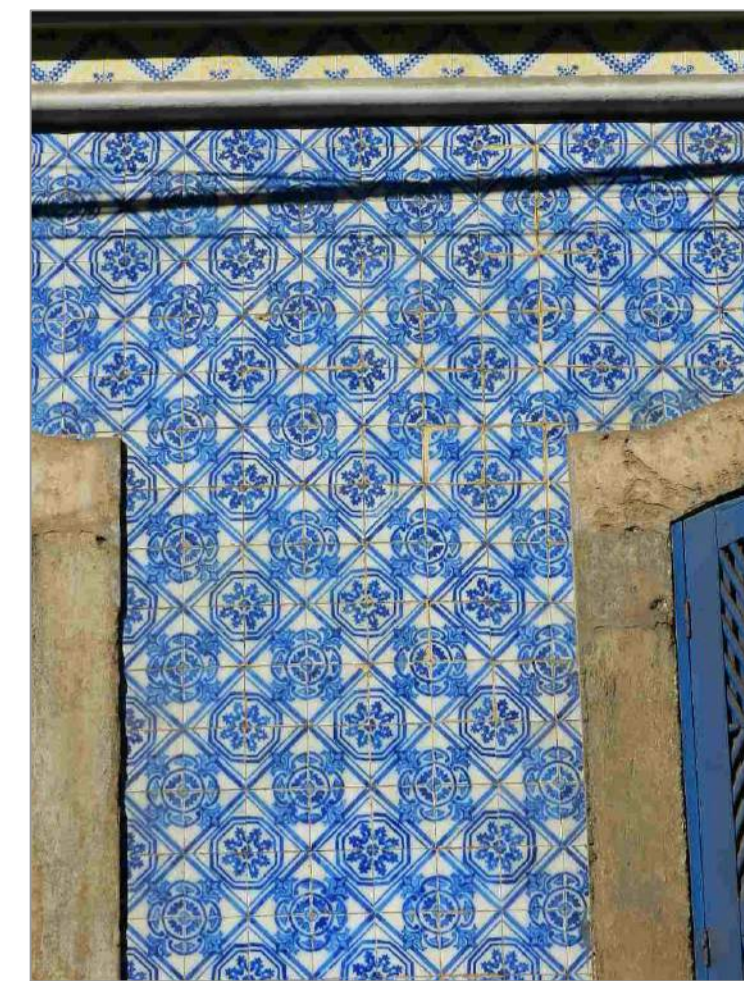
Extremidade superior do painel 5.
