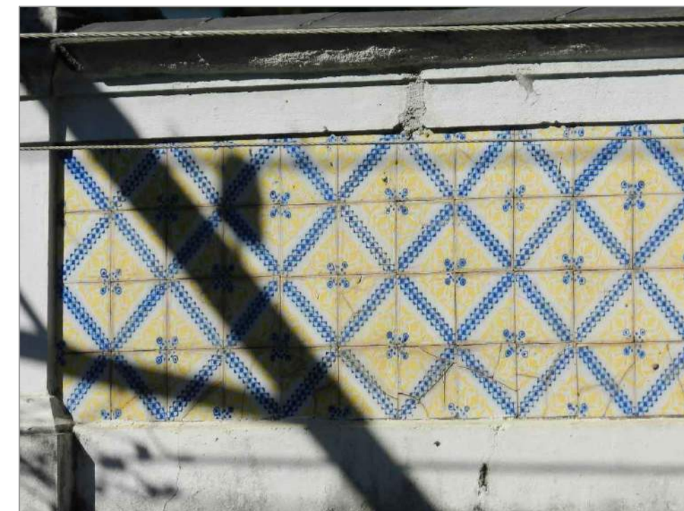
Extremidade direita do painel 16.
