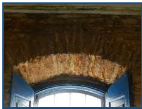
Figura 55: Vista interna do muro da fachada do edifício azulejado.
