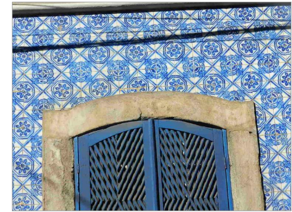
Extremidade superior do painel 4.
