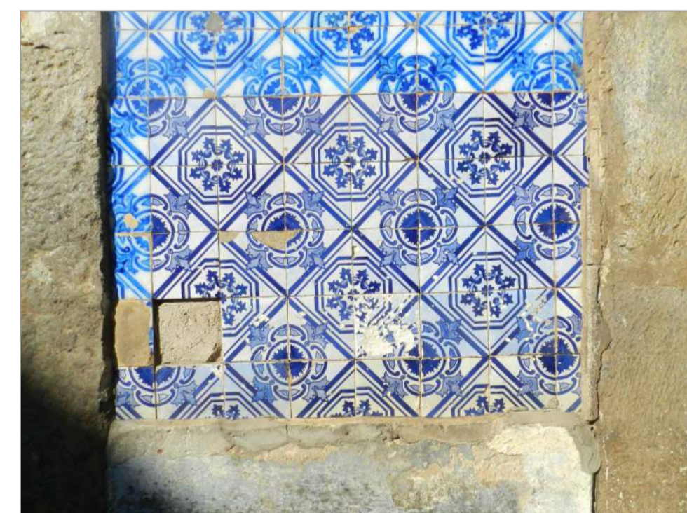
Extremidade inferior do painel 13.
