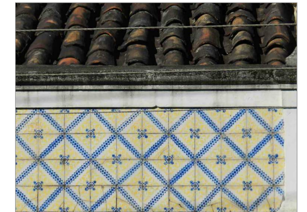
Extremidade esquerda do painel 18.
