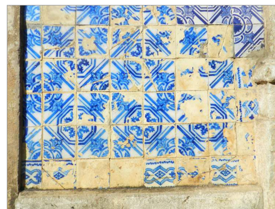
Extremidade inferior do painel 15.
