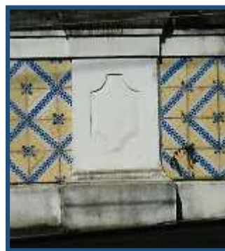
Figura 42: Pilastra da platibanda moldada em estuque. Fonte: Marina Poloni, 2015.
