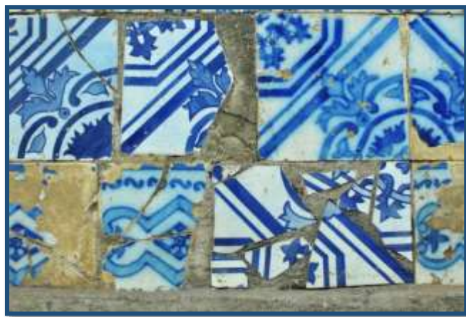
Figura 80: Trecho do painel com simultaneidade de danos, causando desordem azulejar.
