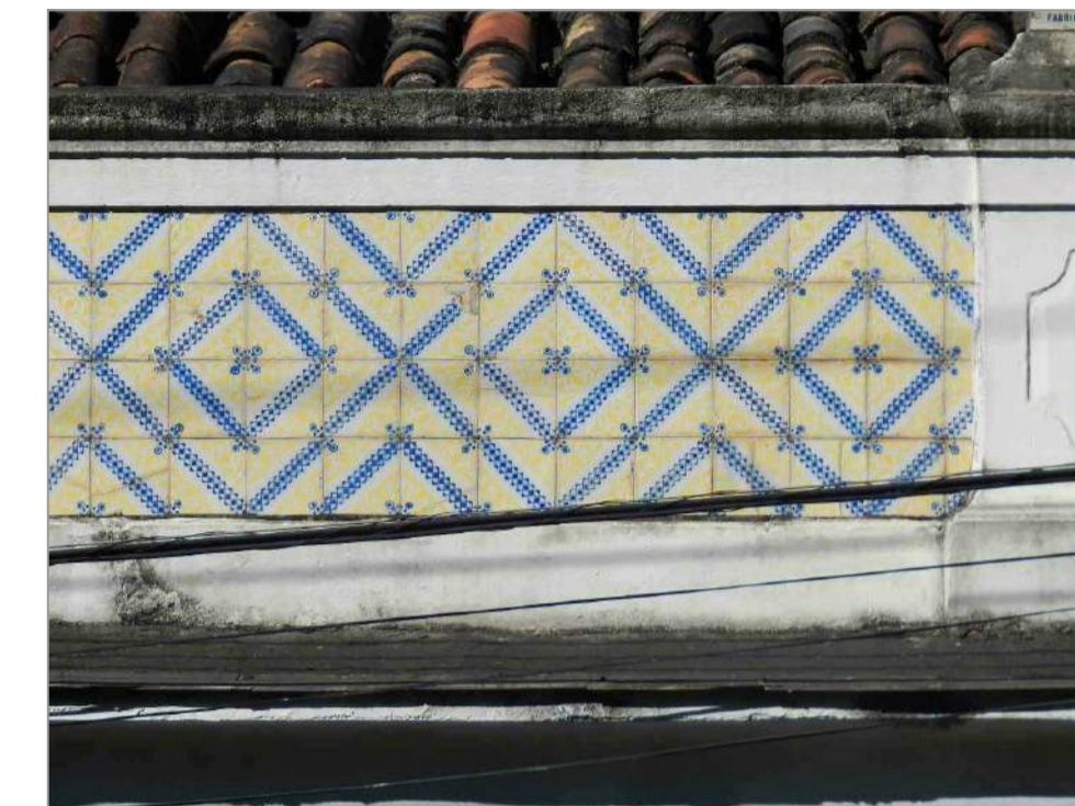
Extremidade esquerda do painel 21.
