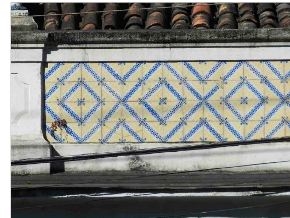
Extremidade direita do painel 21.
