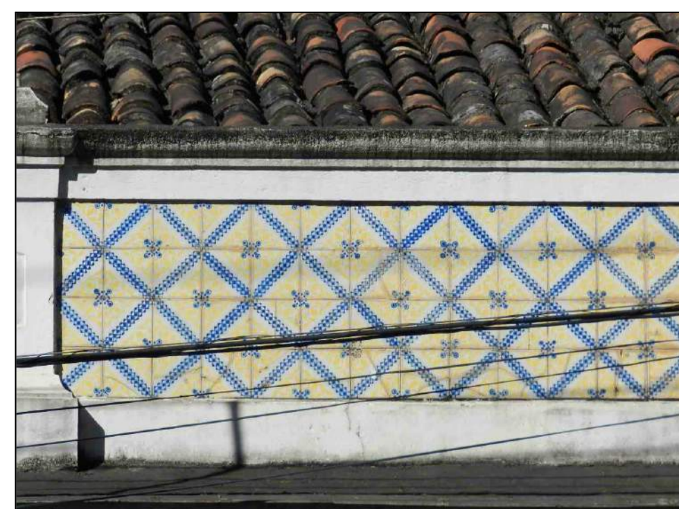
Extremidade direita do painel 22.
