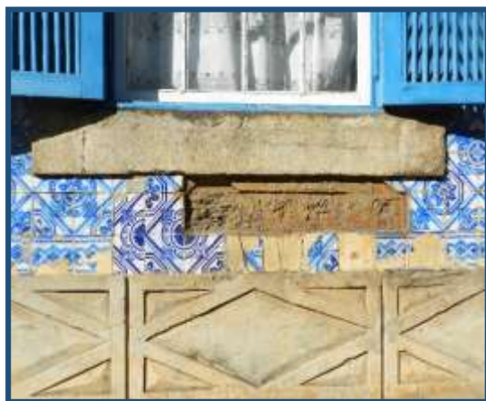
Figura 73: Trecho do painel azulejar abaixo do peitoril de uma das janelas, com lacuna azulejar.
