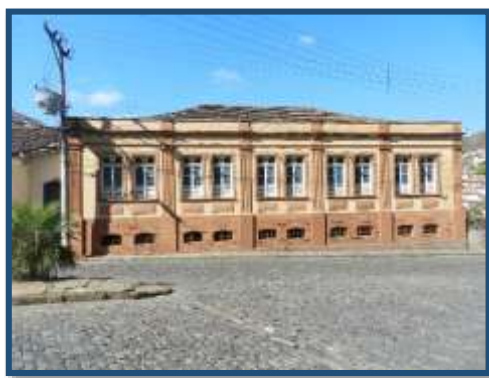
Figura 32: Edifício marrom. Fonte: Marina Poloni, 2015,
