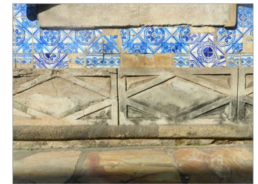
Extremidade inferior do painel 6.
