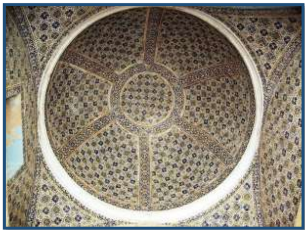
Figura 6: Abóbada da capela-mor da Capela de Nossa Senhora do Pilar – Recife.
