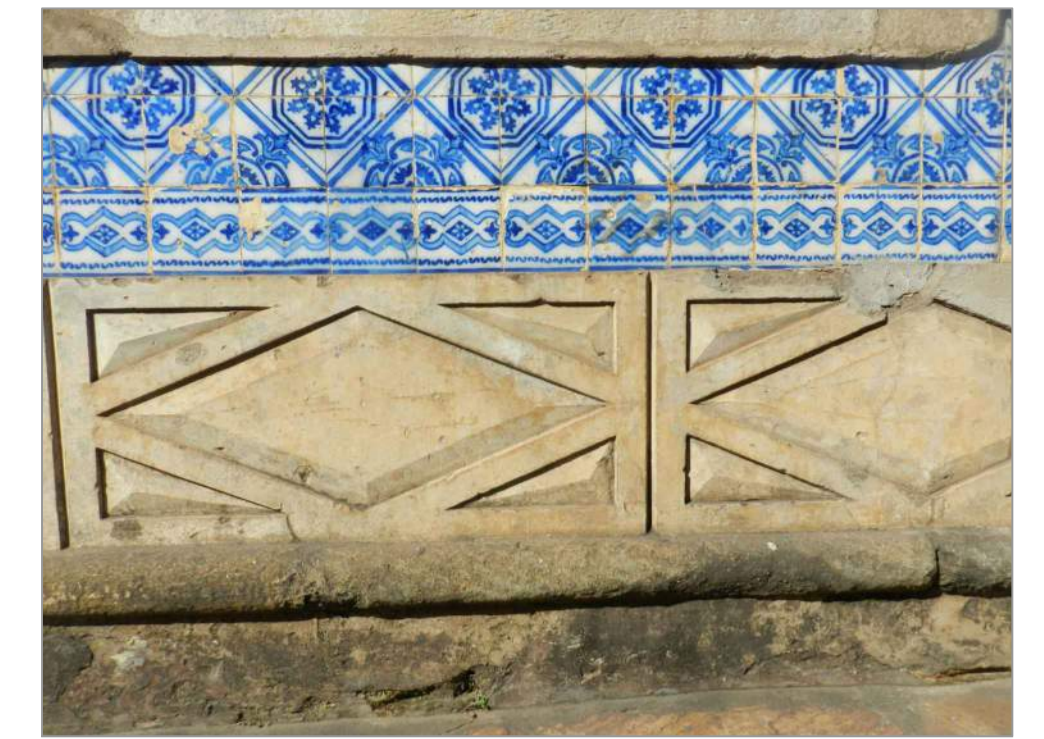
Extremidade superior do painel 2.
