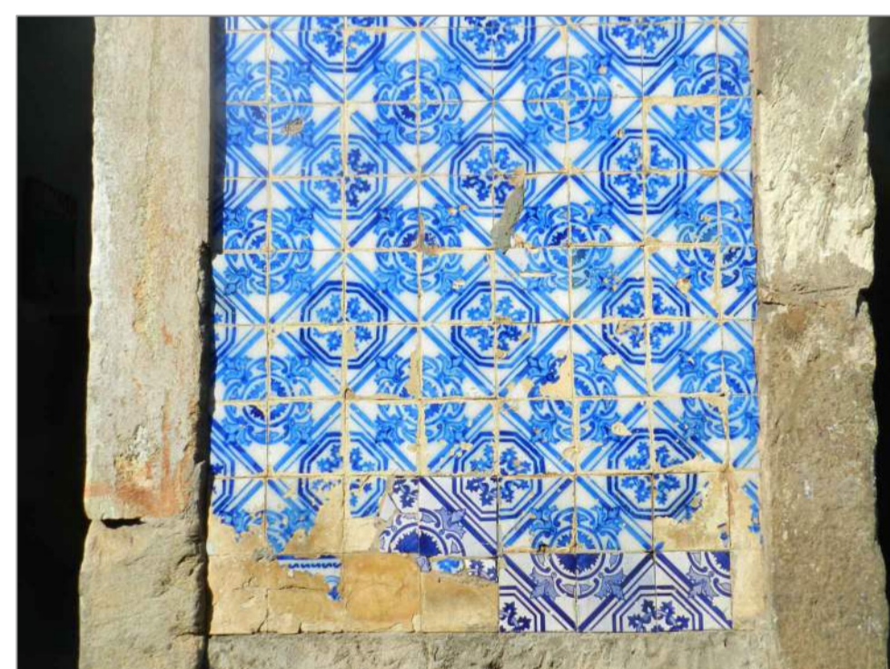
Extremidade inferior do painel 11.
