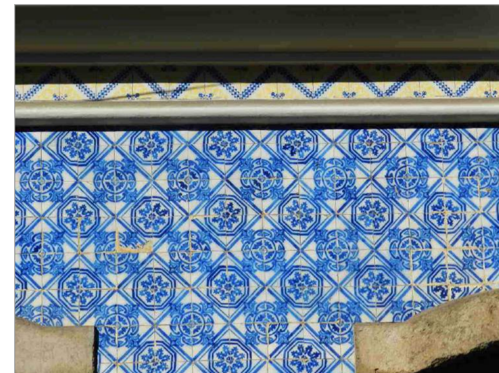
Extremidade superior do painel 13.
