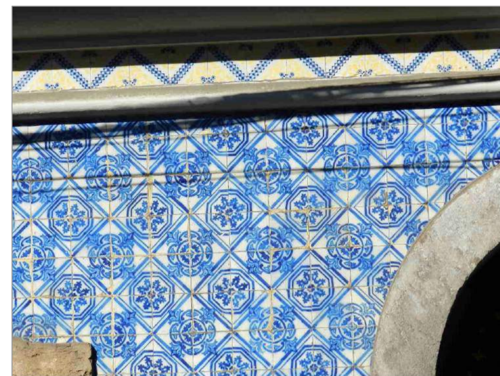
Extremidade superior do painel 7.
