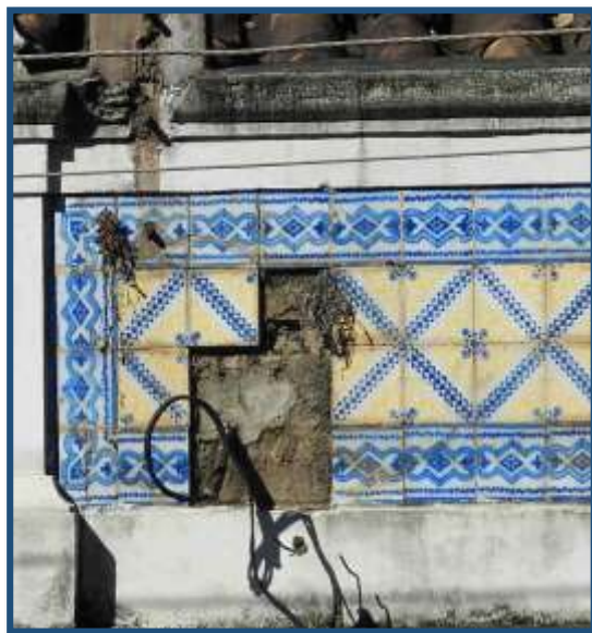
Figura 71: Trecho do painel azulejar da platibanda com perda de peças.
