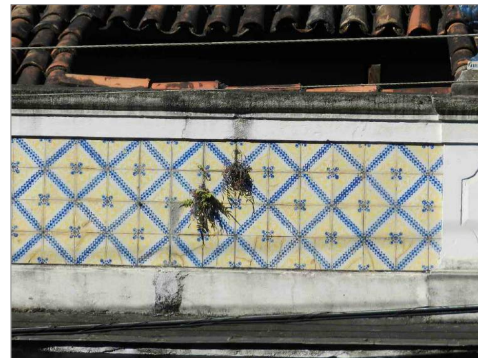
Extremidade esquerda do painel 20.
