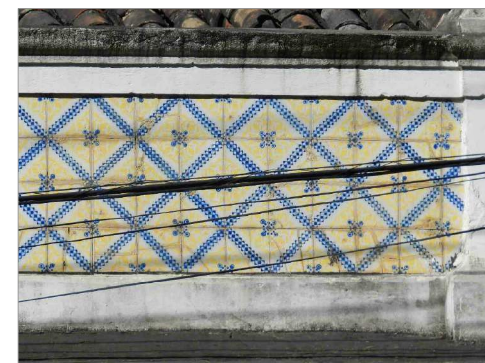
Extremidade esquerda do painel 22.
