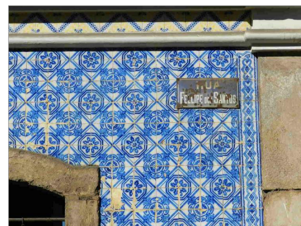
Extremidade superior do painel 15.
