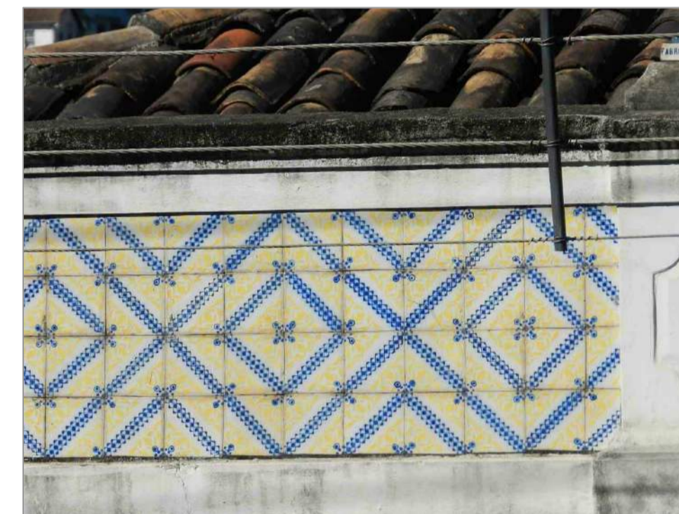
Extremidade direita do painel 17.
