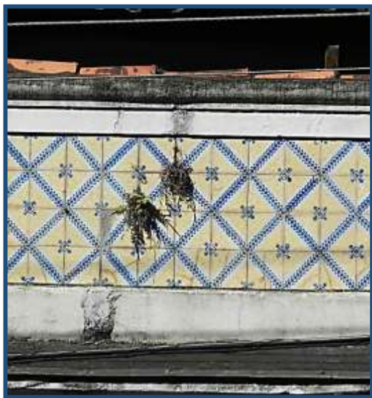
Figura 70: trecho do painel azulejar da platibanda com trincas nas peças da primeira linha.
