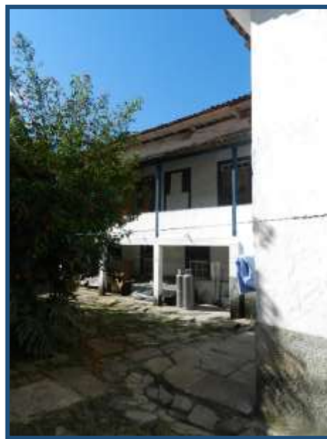
Figura 31: Varanda do edifício anexo, voltada para o quintal. Fonte: Marina Poloni, 2014.
