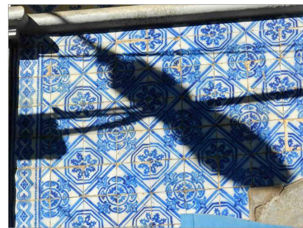
Extremidade superior do painel 1.
