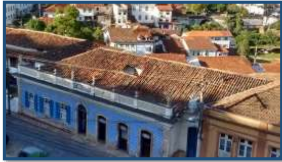
Figura 27: Vista da atual cobertura.
