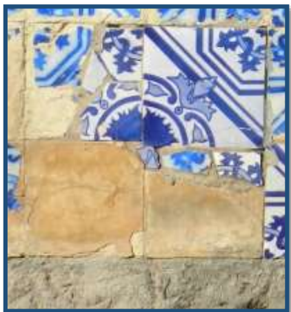
Figura 78: Trecho do painel com simultaneidade de danos, causando desordem azulejar.
