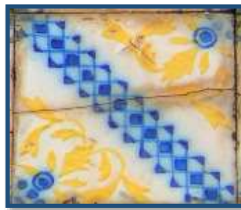
Figura 61: Azulejo da fachada do imóvel em estudo. Tipologia 4. Fonte: Marina Poloni, 2015.
