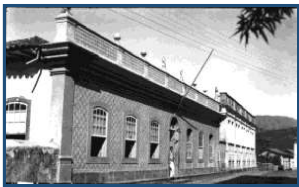
Figura 56: Fachada da Pousada Vila Rica por volta da década de 1930 com porta central ladeada por três janelas de cada lado.
