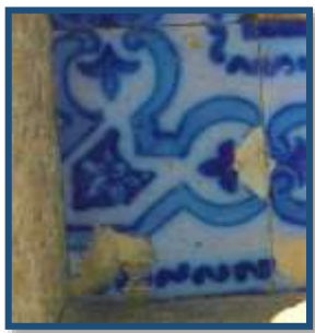
Figura 60: Azulejo da fachada do imóvel em estudo. Tipologia 3. Fonte: Marina Poloni, 2015.
