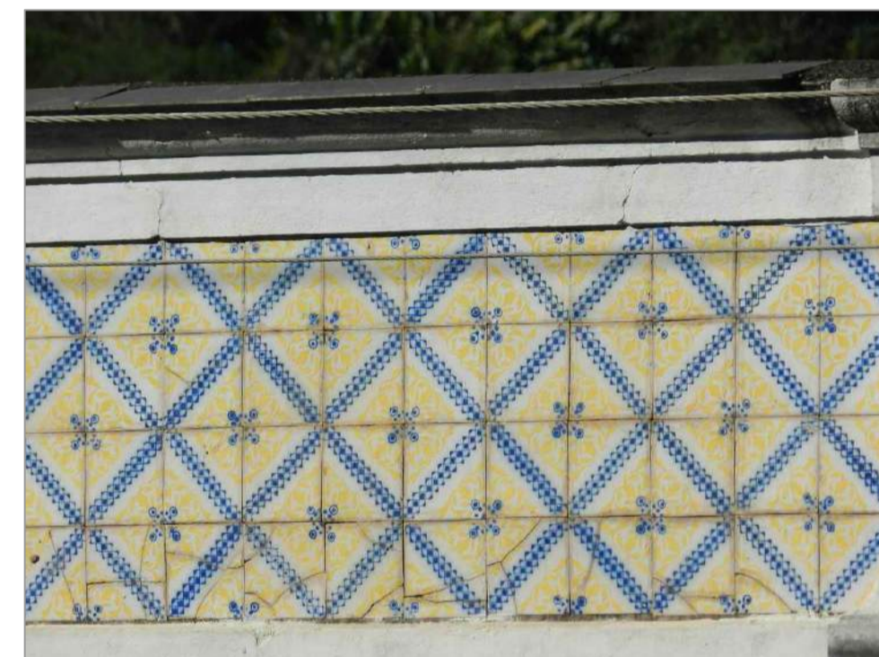
Extremidade esquerda do painel 16.
