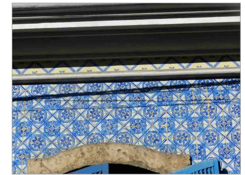
Extremidade superior do painel 6.
