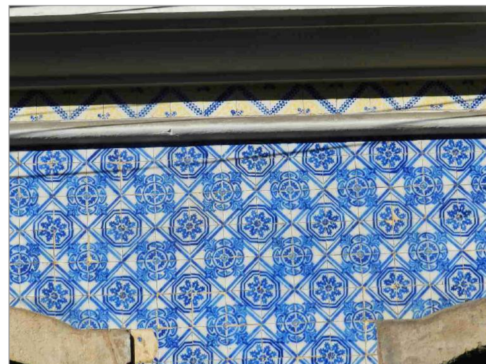
Extremidade superior do painel 11.
