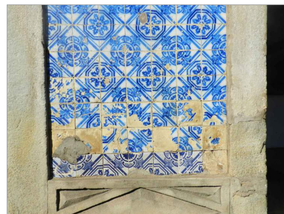
Extremidade inferior do painel 9.
