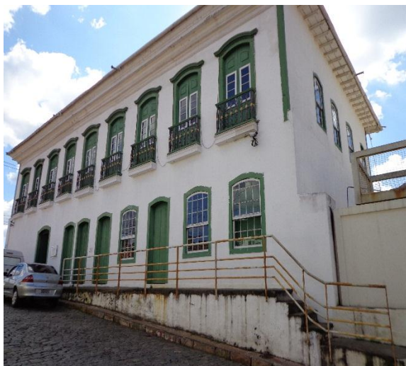
Figura 41: Vista do acesso pela Rua Alvarenga. Fonte: Rânia Figueiredo (Agosto/2014).
