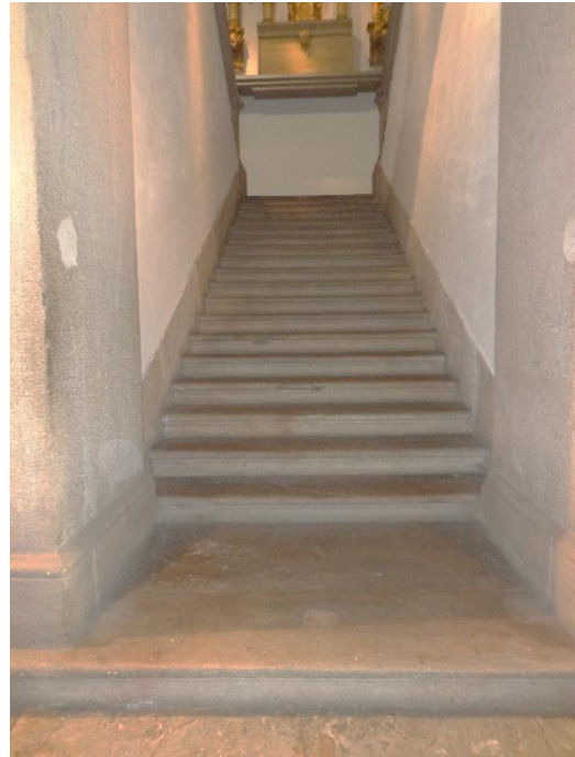
Figura 20: Falta de sinalização tátil de alerta indicando início e término de escadas. Fonte: Rânia Figueiredo (Julho/2014).
