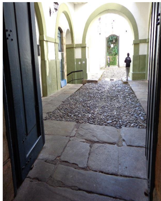
Figura 32: Piso irregular sem sinalização e de acesso limitado. Fonte: Rânia Figueiredo (Agosto/2014).
