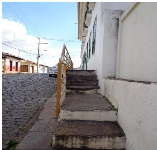
Figura 42: Escada e passarela de acesso à galeria de exposições. Fonte: Rânia Figueiredo (Agosto/2014).
