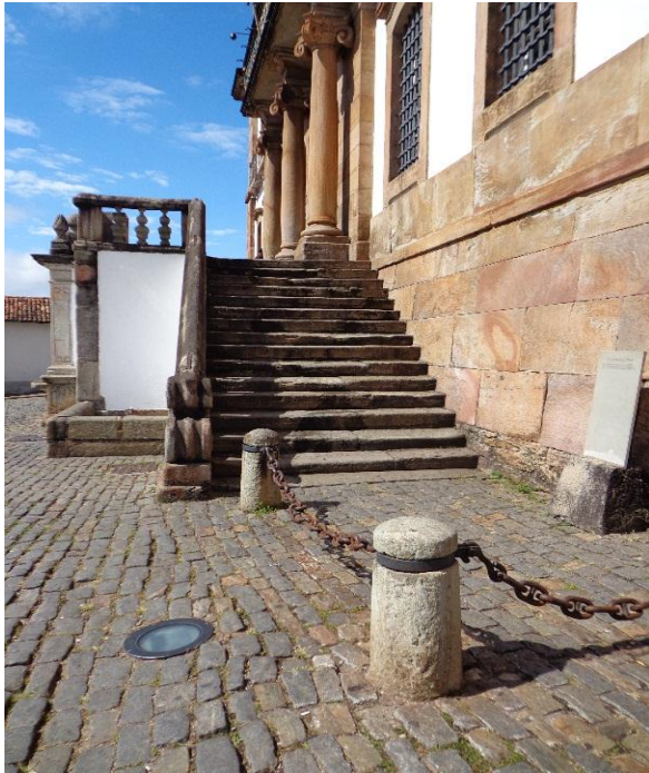
Figura 17: Falta de sinalização quanto ao início das escadas. Fonte: Rânia Figueiredo (Julho/2014).
