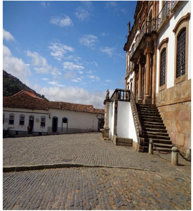
Figura 18: Presença de barreiras arquitetônicas e desnível da calçada. Fonte: Rânia Figueiredo (Julho/2014).
