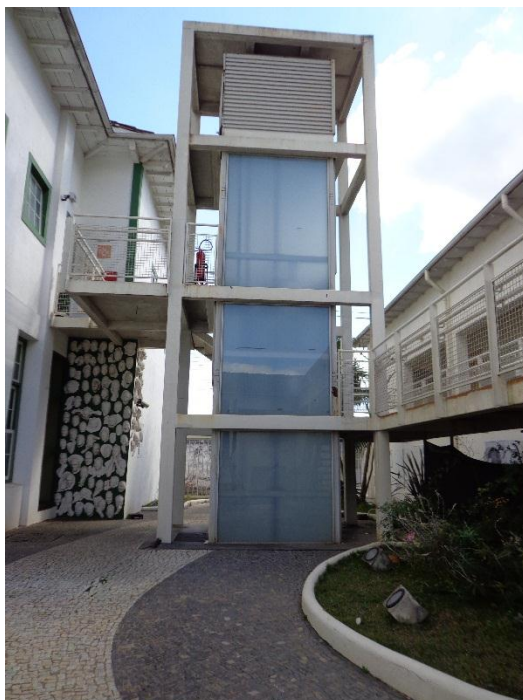
Figura 33: Elevador e estrutura metálica. Fonte: Rânia Figueiredo (Agosto/2014).
