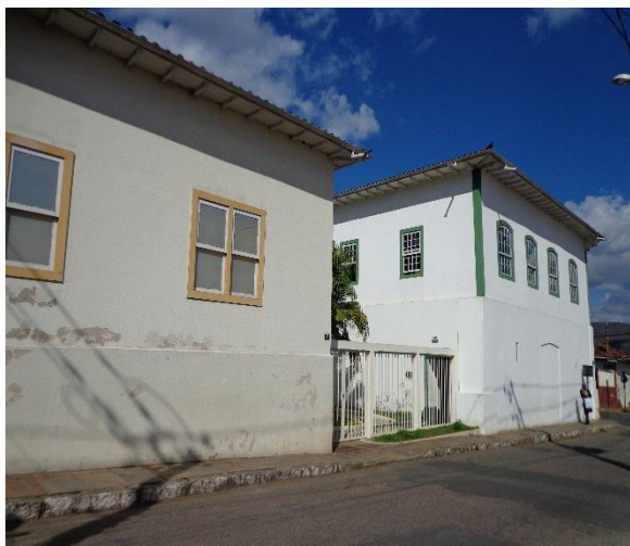
Figura 39: Entorno da edificação, entrada lateral com rebaixamento do passeio. Fonte: Rânia Figueiredo (Agosto/2014).
