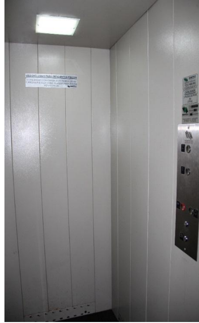
Figura 8: Elevador e instruções de utilização segundo a norma NBR 9050/04. Fonte: Acervo Museu da Inconfidência (Julho/2014).
