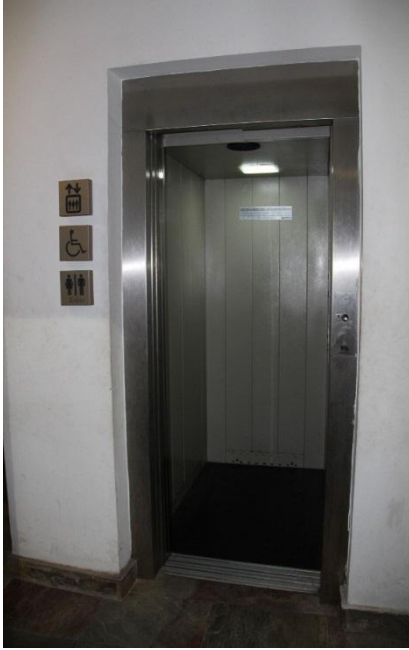
Figura 7: Placas de orientação e identificação do elevador e sanitários. Fonte: Rânia Figueiredo (Julho/2014).
