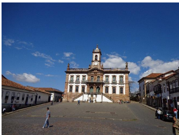
Figura 1: Museu da Inconfidência. Fonte: Rânia Figueiredo (Julho/2014).
