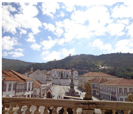
Figura 2: Edificações localizadas no entorno do museu. Fonte: Rânia Figueiredo (Julho/2014).
