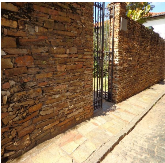
Figura 24: Desnível na calçada da entrada do anexo I. Fonte: Rânia Figueiredo (Julho/2014).
