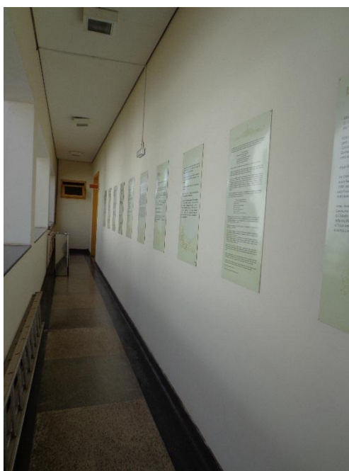
Figura 36: Piso da área interna e corredor estreito. Fonte: Rânia Figueiredo (Agosto/2014).
