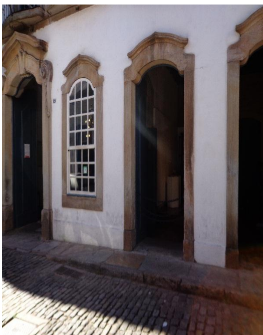
Figura 27: Calçamento irregular no acesso à edificação. Fonte: Rânia Figueiredo (Agosto/2014).
