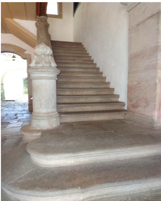
Figura 31: Escadaria sem sinalização tátil de alerta dos degraus. Fonte: Rânia Figueiredo (Agosto/2014).
