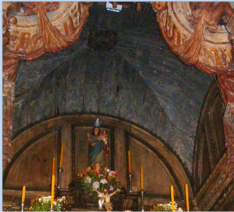
Figura 2: Trono N. S. do Rosário, Cúpula e painéis laterais exibem a presença de Cupim-de-madeira-seca ( Cryptotermes brevis ). Parede direita colonizada anteriormente por intensa atividade de Cupim-de-solo. Fonte: Projeto de desinfestação e de imunização da Igreja Santa Efigênia, Ouro Preto-MG-07/2006
