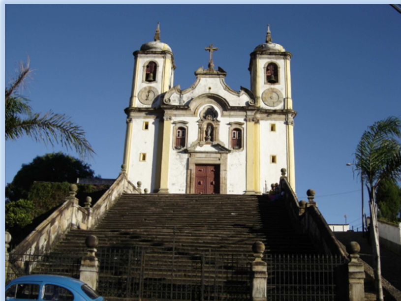
Figura 4: A cantaria da escadaria e adro da igreja e fachada apresentava muita sujeira. A fachada apresentava manchas de infiltração de água sob as janelas, frontal e cúpula das torres. Fonte: Arquivo Hexágono, 2008.
