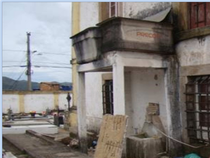
Figura 8: A caixa d'água localizada na fachada dos fundos da igreja, interferindo em seu aspecto visual e ocasionando infiltrações nas paredes foi removida
