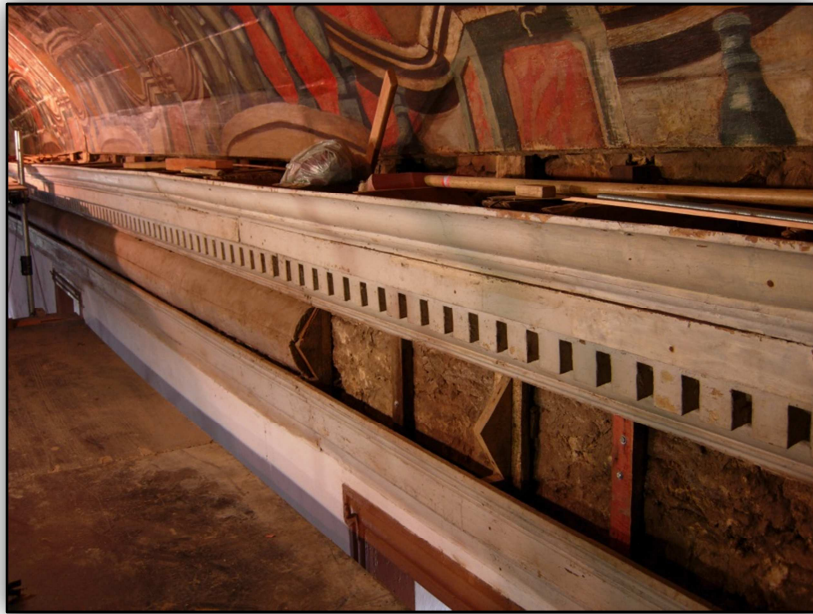
Figura 15: Substituição da cimalha. Fonte: Deise Lustosa 2009
