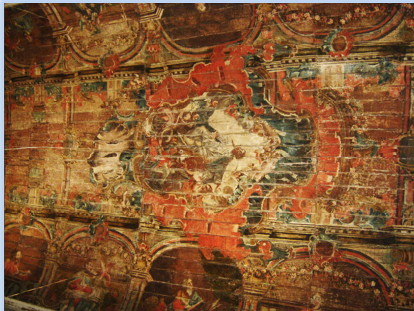
Figura 6: Degradação do forro devido a ação da chuva e insetos xilófagos. Fonte: Arquivo Hexágono, 2008.
