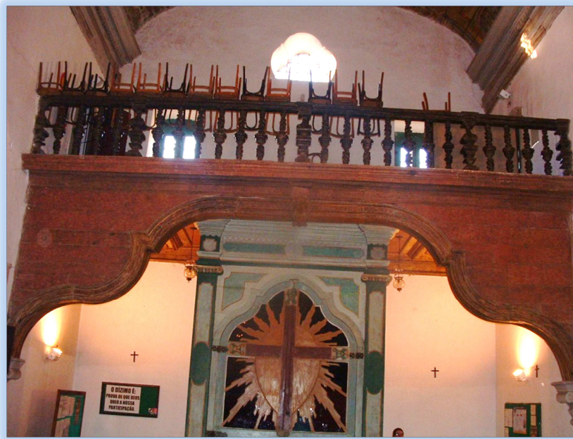
Figura 1: Piso do coro, balaustrada, forro e mão-francesa do átrio. paravento exibia a presença de cupim-de-madeira-seca e umidade proveniente das janelas base dos esteios do paravento. Fonte: Projeto de desinfestação e de imunização da Igreja Santa Efigênia, Ouro Preto-MG-07/2006.
