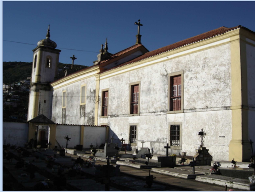
Figura 5: Manchas de umidade em toda a fachada, mais acentuadas sob as seteiras e janelas, cordão, cimalthas e cúpulas das torres. Fonte: Arquivo Hexágono, 2008.
