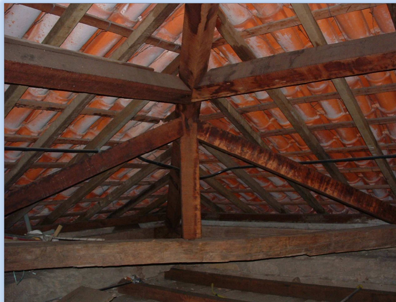
Figura 3: Estrutura do telhado exibiu a presença de Cupim-de-madeira-seca ( Cryptotermes brevis ) em várias vigas remanescentes e fragilizadas. Fonte: Projeto de desinfestação e de imunização da Igreja Santa Efigênia, Ouro Preto-MG-07/2006
