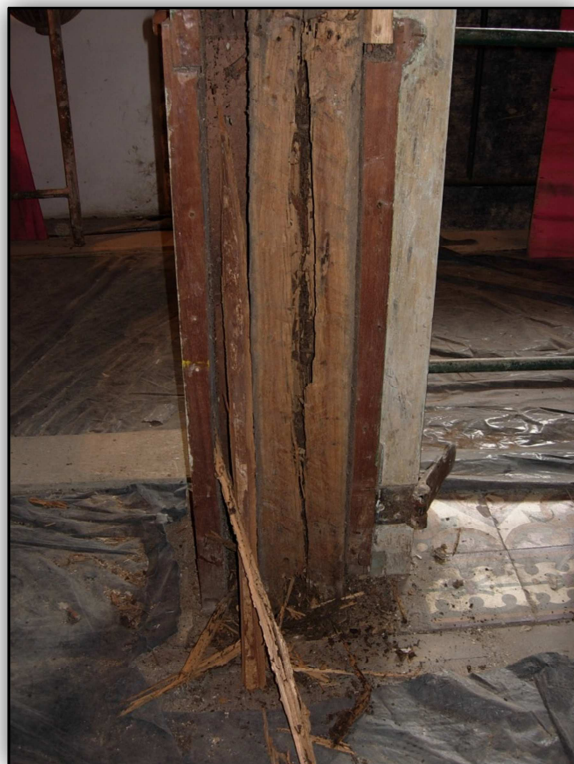
Figura 16: Base do paravento danificada Fonte: Deise Lustosa 2009
