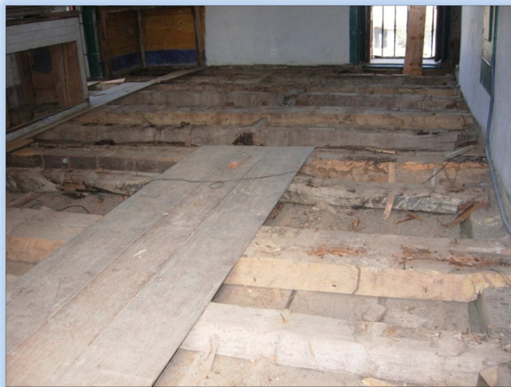
Figura 13: Barroteamento do Piso consistório Fonte: Deise Lustosa 2009
