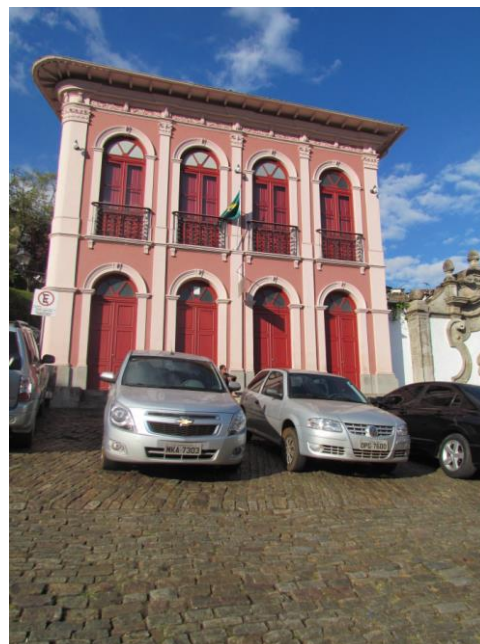
Figura 2: Fotografia atual do antigo Edifício de Banco de Comércio e Indústria de Minas Gerais.
