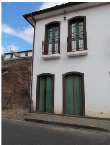
Figura 23: Parte da Fachada da edificação no bairro Vila Aparecida. Fonte: Ana Beatriz Araújo (2014).
