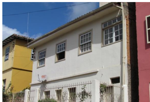
Figura 22: Fachada principal, edificação no bairro Vila Aparecida. Fonte: Ana Beatriz Araújo (2014).
