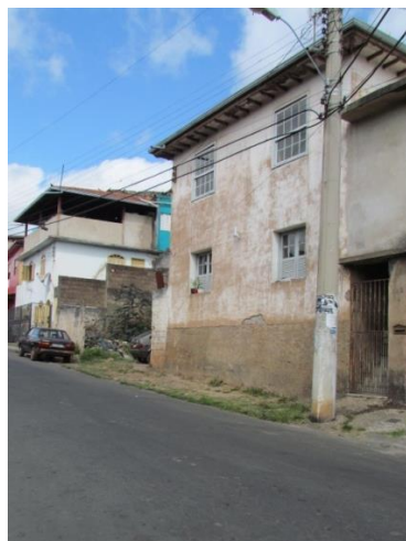
Figura 24: Fachada principal da edificação no bairro Vila Aparecida. Fonte: Ana Beatriz Araújo (2014)
