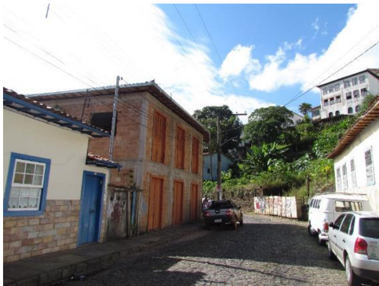
Figura 8: Exemplificação de edificação inacabada, construída no chamado centro histórico, com tipologia colonial, futura pastiche. Fonte: Ana Beatriz Araújo (2014)
