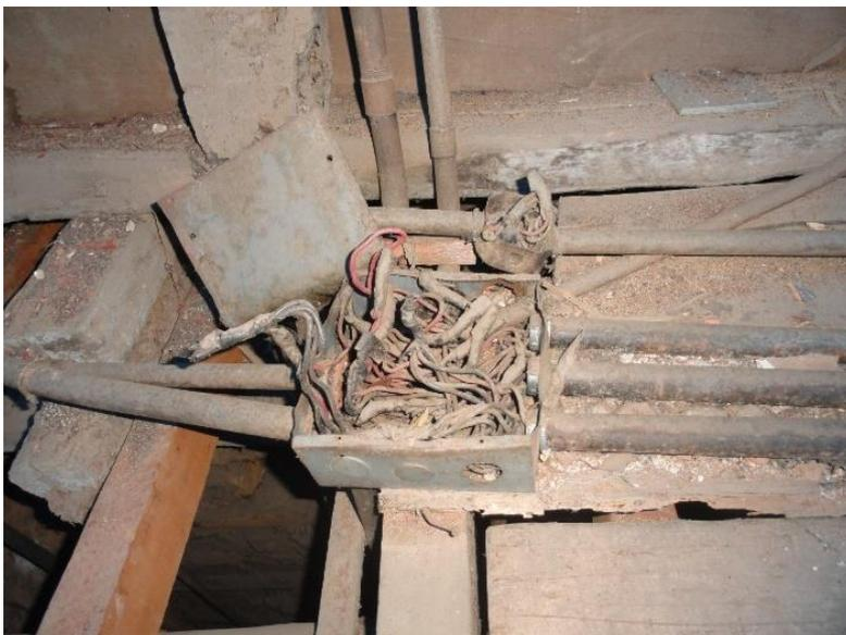
Figura 32- Instalações elétricas precárias
