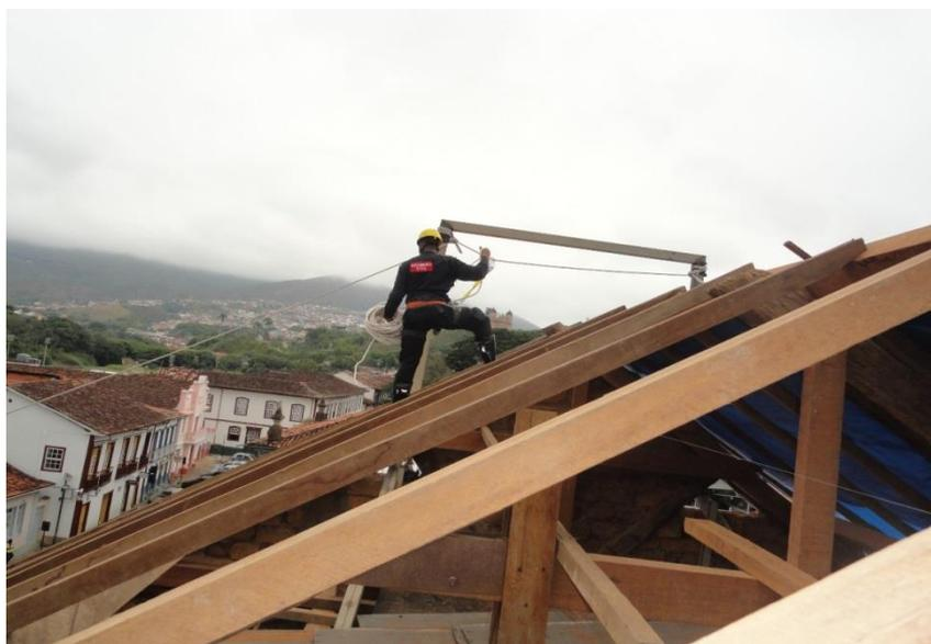
Figura 28- Sistema ancoragem bombeiro civil
