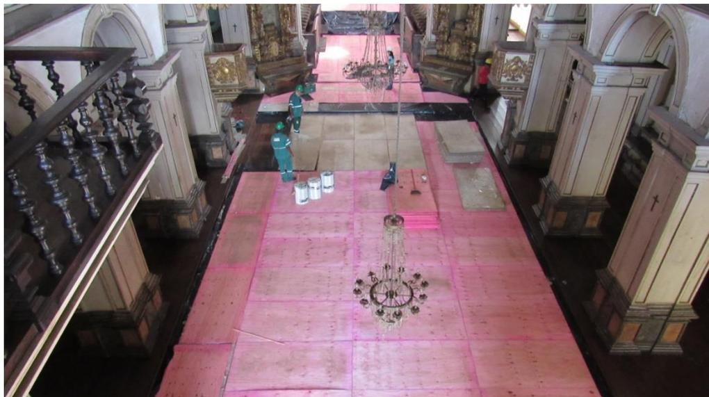
Figura 38 - Proteção do piso da nave central
