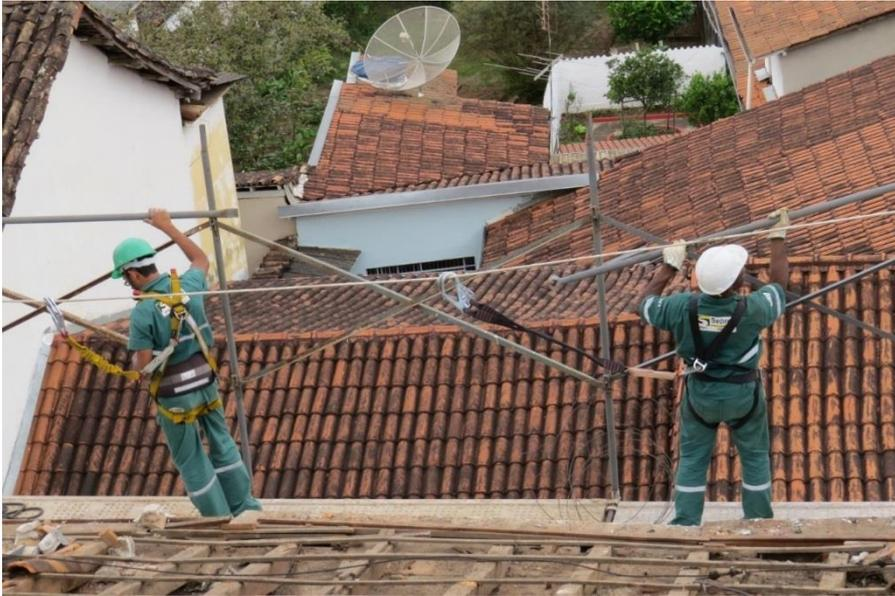
Figura 29 - Colaboradores com sistema ancoragem
