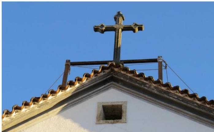
Figura 27- Sistema de ancoragem
