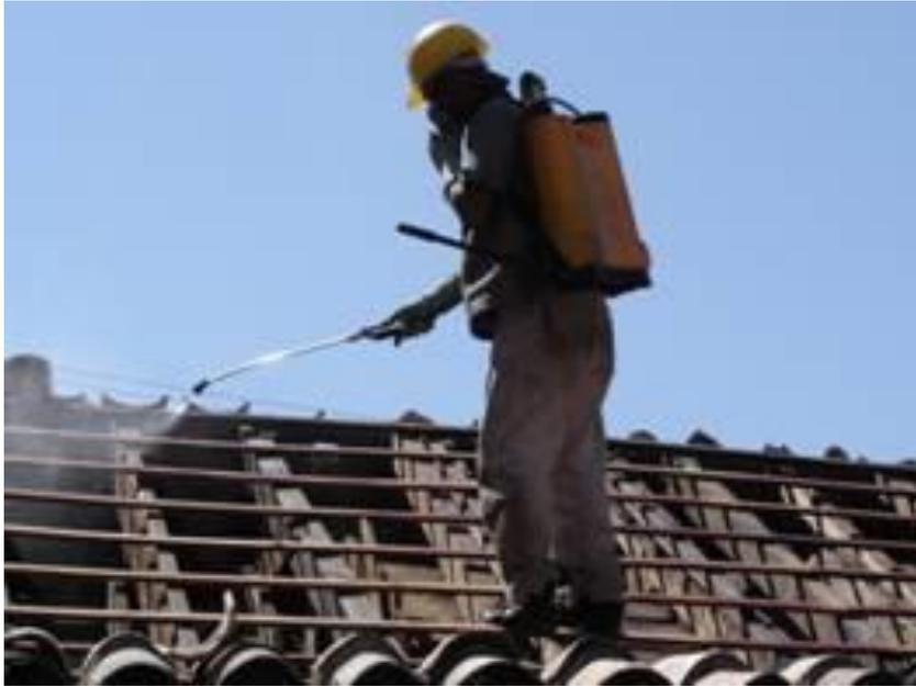
Figura 16 – Imunização da cobertura do telhado da Capela de Santana em Ouro Preto
