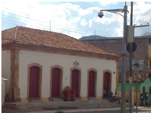
(b) Após Intervenção
