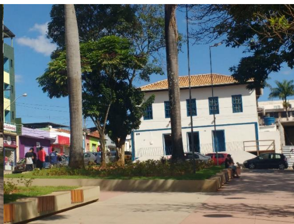
(h) Praça após a revitalização
