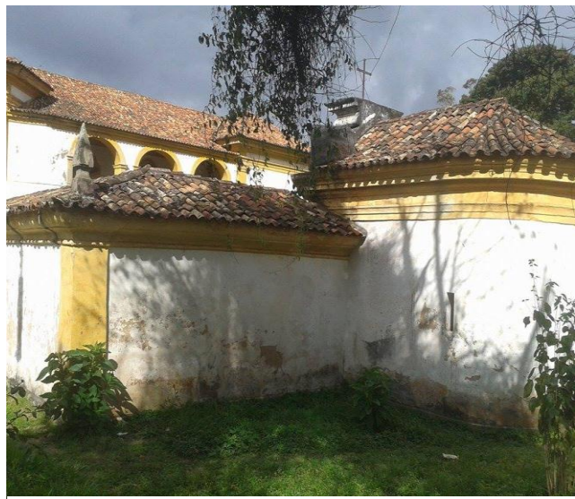
FIGURA 48: Vista posterior do cemitério. Destaque para a planta semicircular da capela mortuária. Cemitério de São Francisco de Assis, Ouro Preto. Fonte: ACERVO DO AUTOR, 2017.
