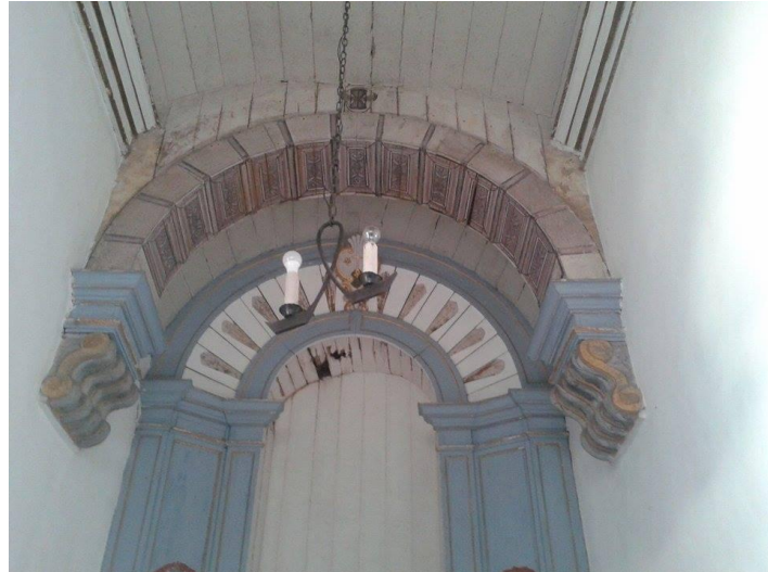
FIGURA 39: Retábulo degradado por xilófagos. Cemitério do Carmo, Ouro Preto.
