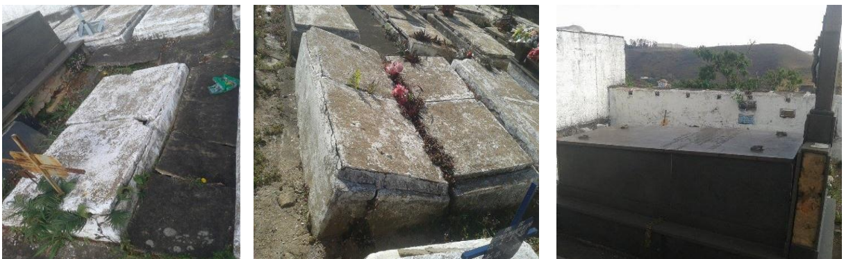
FIGURA 21: Sequência de túmulos em estado de deterioração avançado. Cemitério Mercês de Cima, Ouro Preto.
