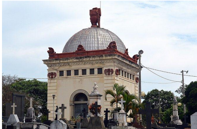
FIGURA 2: Edifício Necrotério construído em 1897. Cemitério do Bonfim, Belo Horizonte.
