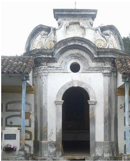
FIGURA 47: Vista frontal da Capela Mortuária. Cemitério de São Francisco de Assis, Ouro Preto. Fonte: ACERVO DO AUTOR, 2017.
