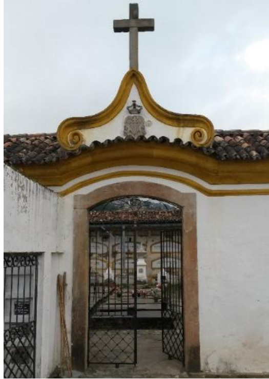
FIGURA 52: Entrada do Cemitério das Mercês e Perdões, Ouro Preto.
