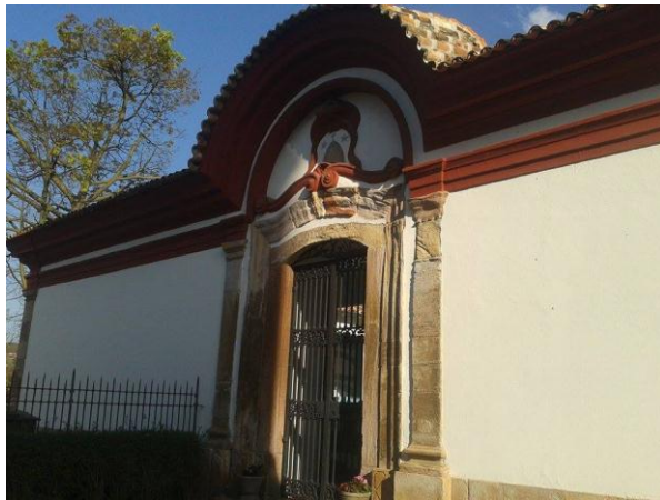
FIGURA 26: Vista frontal do cemitério fechado. Portão de ferro emoldurado por cantaria, encimado pela emblemática da Ordem. Cemitério do Carmo, Ouro Preto.
