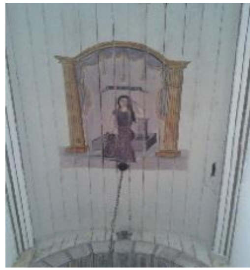
FIGURA 38: Pintura do forro da Capela Mortuária. Com aparentes patologias causadas por xilófagos. Cemitério do Carmo, Ouro Preto. Fonte: ACERVO DO AUTOR, 2017.
