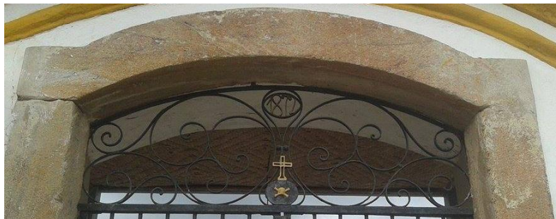
FIGURA 51: Portão emoldurado por cantaria de verga curvada. Destaque para a bandeira com a data 1872 e os símbolos mortuários. Cemitério das Mercês e Perdões, Ouro Preto.
