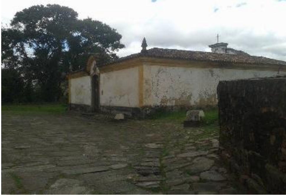
FIGURA 43: Vista da frente e lateral direita do cemitério. Cemitério de São Francisco de Assis, Ouro Preto. Fonte: ACERVO AUTOR, 2017.
