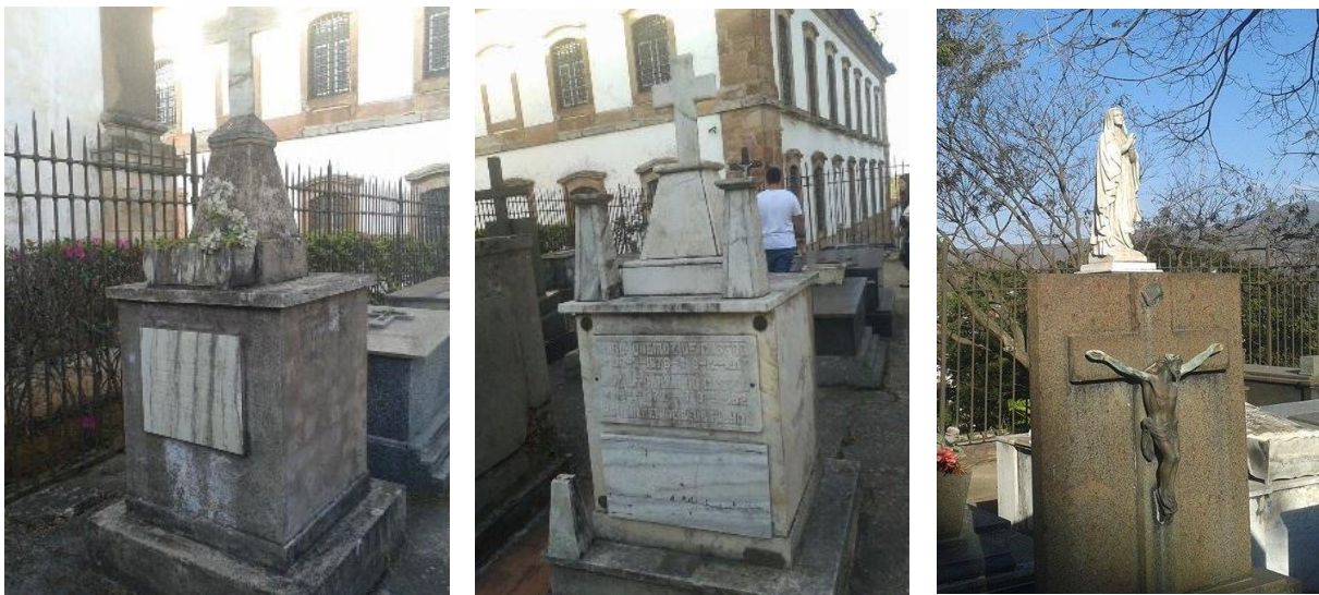
FIGURA 25: Sequência de jazigos esculpidos em pedra, mármore e granito com detalhes ornamentais mortuários. Patologias devido as intempéries a que estão expostos. Cemitério do Carmo, Ouro Preto.
