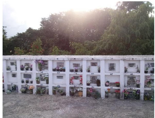
FIGURA 66: Gavetas verticais ossarias. Cemitério de São Miguel e Almas, Ouro Preto. Fonte: ACERVO DO AUTOR, 2017.
