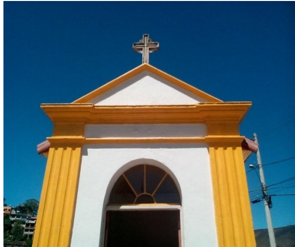
FIGURA 85: Capela Mortuária Cemitério de Santa Efigênia, Ouro Preto. Fonte: ACERVO DO AUTOR, 2017.
