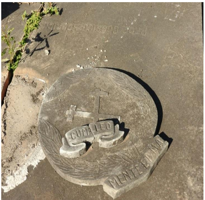
FIGURA 98: Túmulos se deteriorando e perdendo parte da sua arte. Cemitério de São Francisco de Paula, Ouro Preto.
