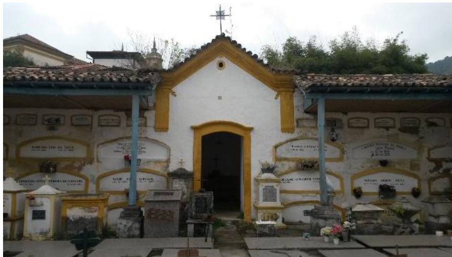
FIGURA 57: Capela Mortuária da Igreja Nossa Senhora das Mercês de Baixo. Fonte: JULIANA VIEIRA, 2016.
