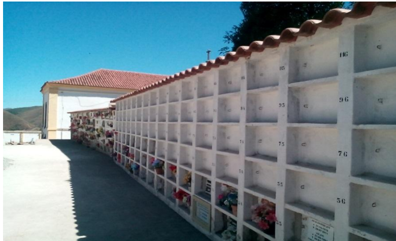
FIGURA 78: Gavetas ossarias do Cemitério de Santa Efigênia, Ouro Preto.
