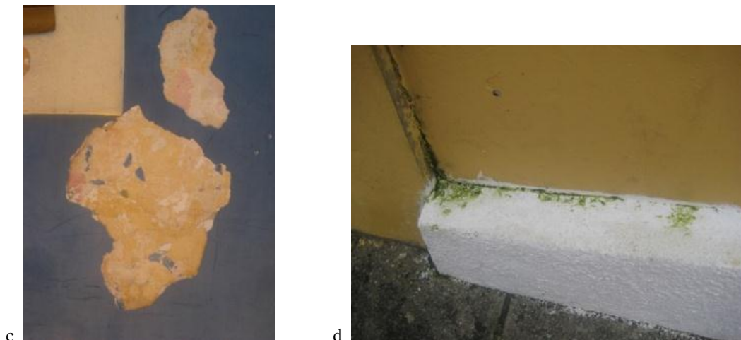
Figura 2 – Degradação comum de tintas sintéticas aplicadas em edificações antigas. 2c - Olinda: destacamento e rachaduras das camadas de tintas látex. 2d - João Pessoa: fungos em edificação recém pintada na Praça Antenor Navarro.
