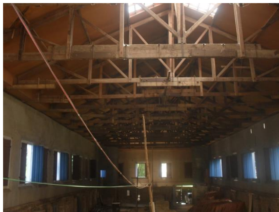
Foto 1-Tipo de madeiramento que se aplicava óleo queimado. Fonte: Acervo pessoal
