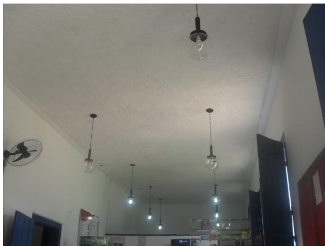
Foto 3- Forro pintado do ICHS.
