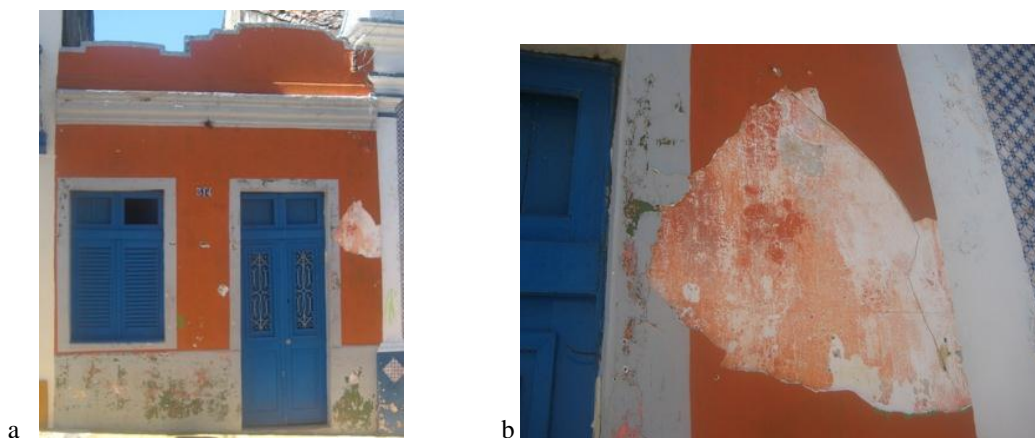
Figura 2 – Degradação comum de tintas sintéticas aplicadas em edificações antigas.
