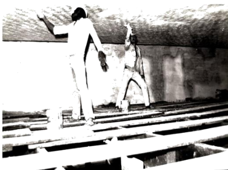
Foto 2- Preparando o forro do ICHS para receber a pintura.
