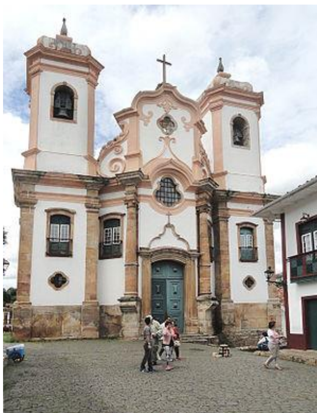
Foto 13-Igreja Nossa Senhora do Pilar após restauração.
