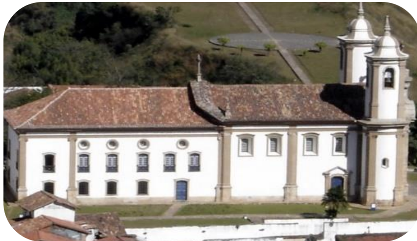
Fotos 12- Fachada lateral da Igreja Nossa Senhora do Carmo após a restauração.
