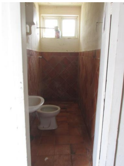
Figura 39: Banheiro da estação. Fonte: Acsa Caroline, 2017.
