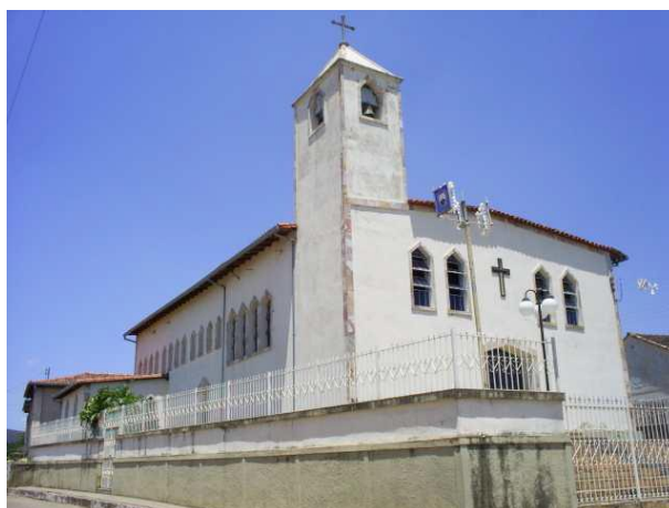
Figura 17: Imagem da igreja de Santo Antônio, depois da reforma.
