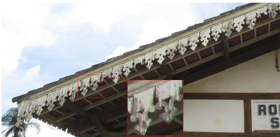
Figura 56: Lambrequim em destaque da estação ferroviária. Fonte: Acsa Caroline.
