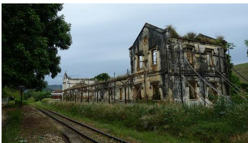
Figura 6: Estação Ferroviária de Chiador.
