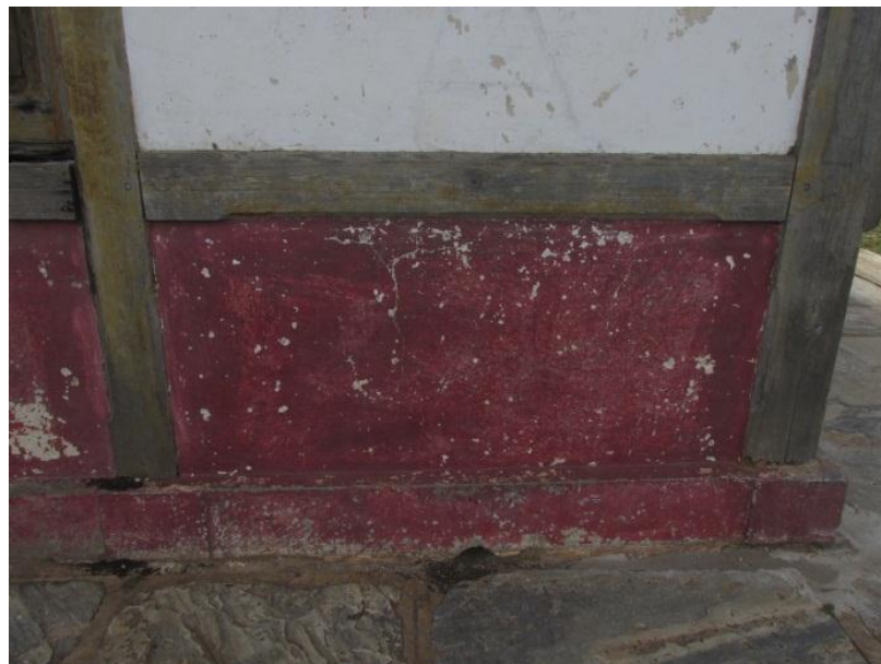
Figura 32: Detalhe da viga da estrutura em madeira. Fonte: Acsa Caroline, 2017.
