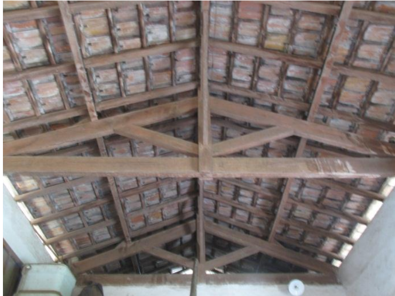
Figura 31: Telhado em estilo tesoura com asnas do armazém. Fonte: Acsa Caroline, 2017.
