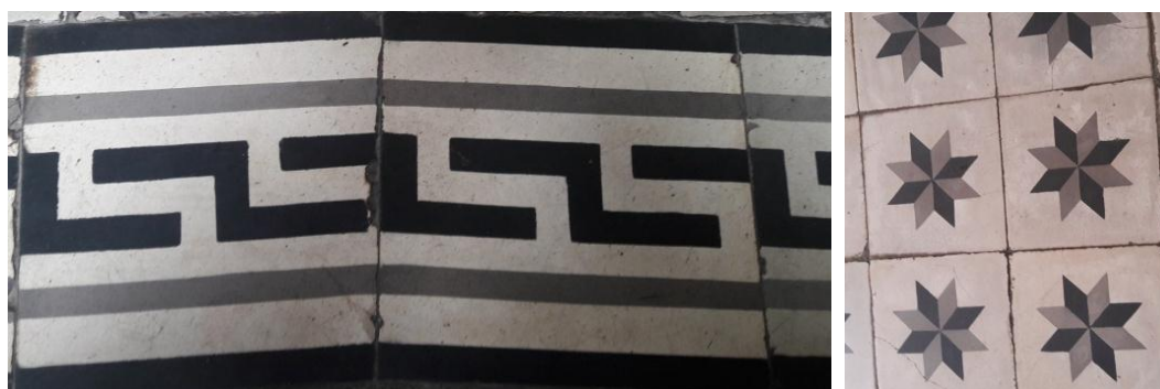
Figura 86: Fita de ladrilhos envolvidos na borda das outras peças. Ladrilhos do corredor e sacristia da igreja. Foto: Sabrina Castro. Março; 2018.
