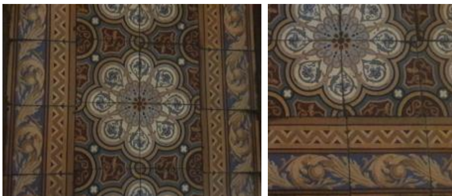
Figura 79: Tapete central de ladrilho hidráulico da Igreja do Rosário/OP. Foto: Sabrina Castro, Março 2018.
