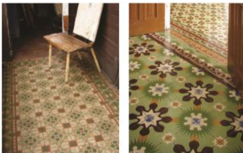
Figura 10: Designs de ladrilhos hidráulicos em varandas de duas edificações de Porto Rico.
