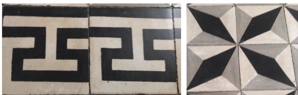
Figura 75: Fita de ladrilhos geométricos que compõe o conjunto do corredor. Foto: Sabrina Castro, Março 2018.
