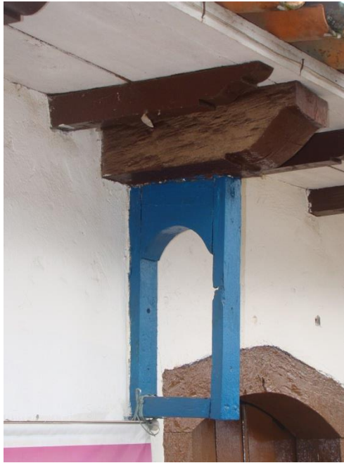
Figura 128: Estrutura para sino. Fonte: Patrícia Roiko Oliveira, 23 fev 2018.
