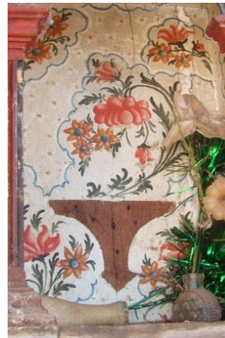
Figura 113: Detalhe falta peanha. Fonte: Patrícia Roiko Oliveira, 27 ago 2017.
