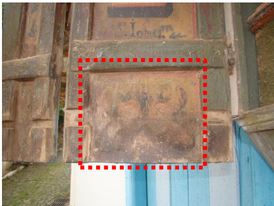
Figura 97: Detalhe parte interna porta esquerda. Fonte: Patrícia Roiko Oliveira, 23 fev 2018.
