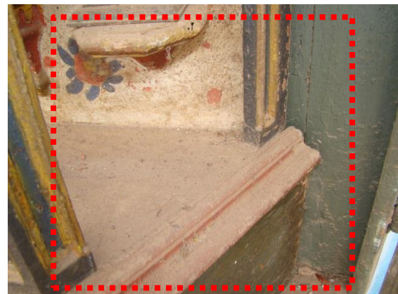
Figura 102: Detalhe fundo da parte móvel. Fonte: Patrícia Roiko Oliveira, 23 fev 2018.
