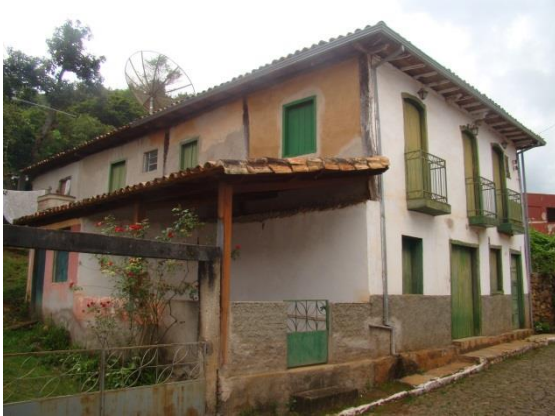
Figura 105: Acréscimo lateral nos fundos. Fonte: Patrícia Roiko Oliveira, 22 fev 2018.
