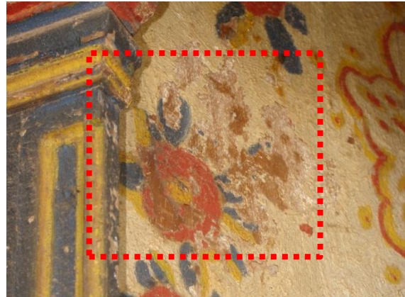
Figura 100: Detalhe fundo da parte móvel. Fonte: Patrícia Roiko Oliveira, 23 fev 2018.
