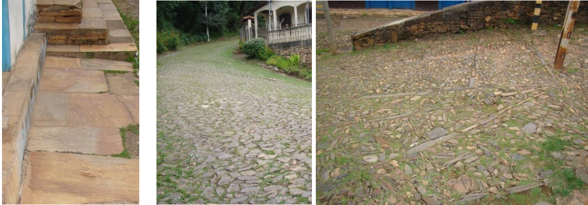
Figura 64: Passeio em laje de pedra. Figura 65: Via pública em poliédrico. Figura 66: Pé de moleque. Fonte: Patrícia Roiko Oliveira, 23 fev 2018.
