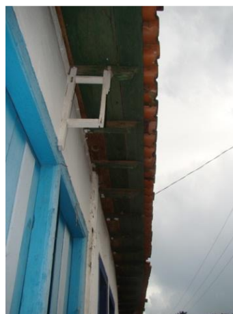
Figura 78: Detalhe do coroamento. Fonte: Patrícia Roiko Oliveira, 14 jan 2018.
