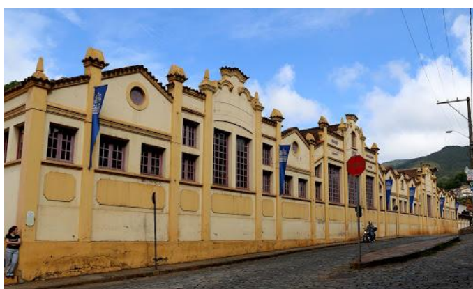
Foto 5- Fachada frontal do Centro de Convenções da UFOP, antigo Parque Metalúrgico.
