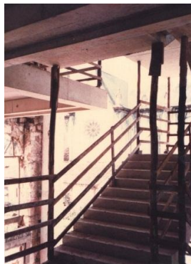
Figura 47: Durante a construção da estrutura nova (2)./Foto: MENICONI, 1986.
