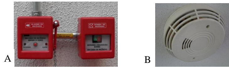
Figura 3: A - Amostra de alarme de incêndio; B - Amostra de detector de fumaça e calor./Fontes: A - Disponível em: < http://www.activepro.com.br/?portfolio=alarme-de-incendios-e-gases >; B - Disponível em: < http://www.abc.net.au/news/2011-07-11/house-fire-deaths-prompt-smoke-alarm-push/2789670 >. Acessos em: 15 set. 2017.
