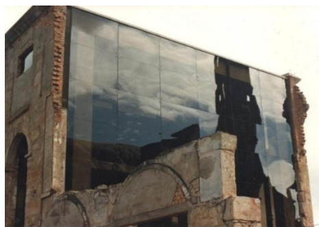
Figura 49: Perspectiva diagonal da nova fachada lateral (1)./Foto: MENICONI, 198[?].
