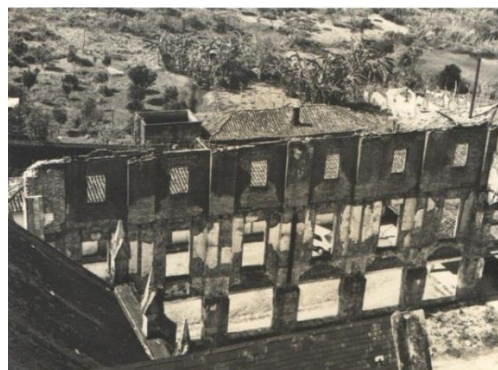
Figura 36: Resultados do incêndio: interior de uma das fachadas extensas./Foto: MENICONI, R.
