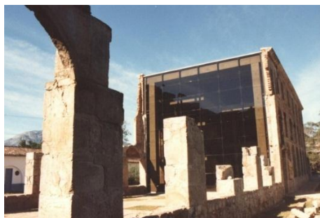
Figura 50: Perspectiva diagonal da nova fachada lateral (2)./Foto: MENICONI, 198[?].
