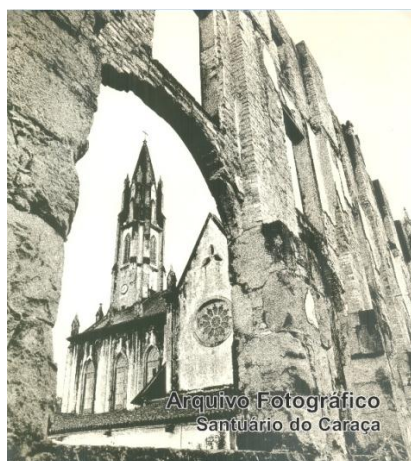
Figura 33: Detalhe do vão em arco pleno e o estado de degradação da estrutura de rochas./Fonte: Arquivo fotográfico da Biblioteca do Caraca.
