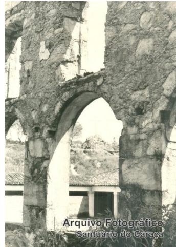
Figura 34: Detalhe da fachada em estrutura de pedra./Fonte: Arquivo fotográfico da Biblioteca do Caraça.
