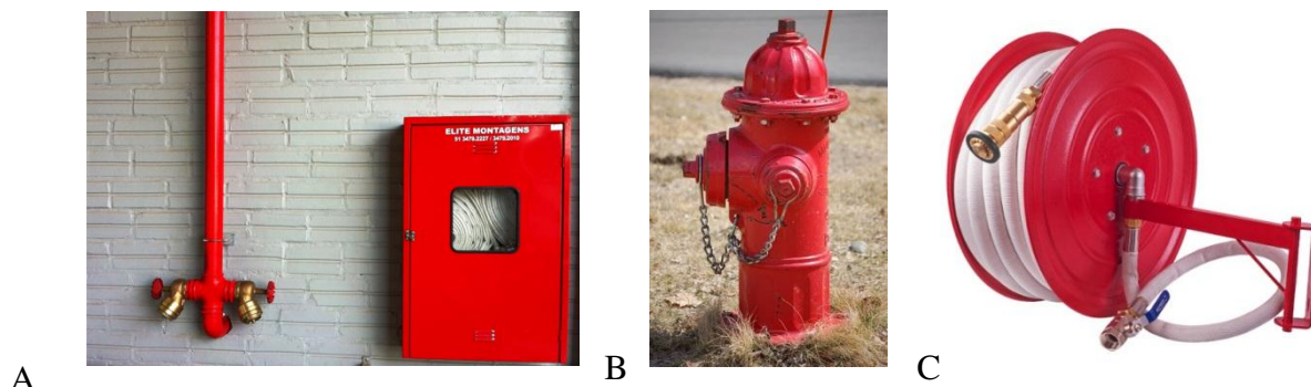
Figura 6: A - Amostra de sistema de hidrante interno à arquitetura; B - Amostra do hidrante externo à arquitetura; C - Amostra de mangotinho./Fontes: A - Disponível em: < http://elitemontagens.web2128ft.uni5.net/Servicos.aspx?codServ=344 >; B - Disponível em: < http://aguasdejoinville.blogspot.com.br/2010/06/uma-parceria-contra-o-incendio.html >; C - Disponível em: < http://zimmex.com.br/produto/hidraulica/mangueiras/carretel-basculante-mangotinho-1-x-30-metros-completo-335/ >. Acessos em: 15 set. 2017.
