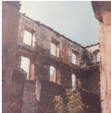
Figura 42: Pós-incêndio e intempéries: ala direita (2)./Foto: MENICONI, R.
