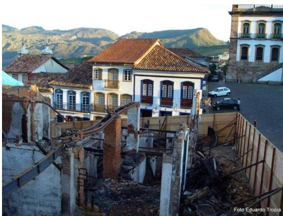
Figura 14: Resultado do incêndio sofrido pelo Hotel Pilão (2)./Fonte: TRÓPIA, E., Disponível em: < https://www.kickante.com.br/campanhas/desfile-de-moda-incendio-hotel-pilao-mg >. Acesso em: 06 fev. 2018.
