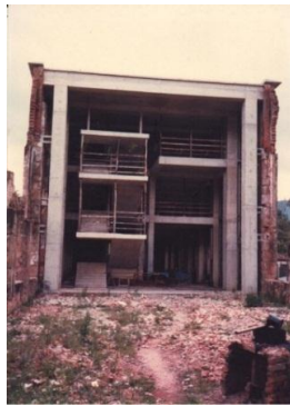
Figura 46: O pé direito triplo e a construção da escada./Foto: MENICONI, 1986.
