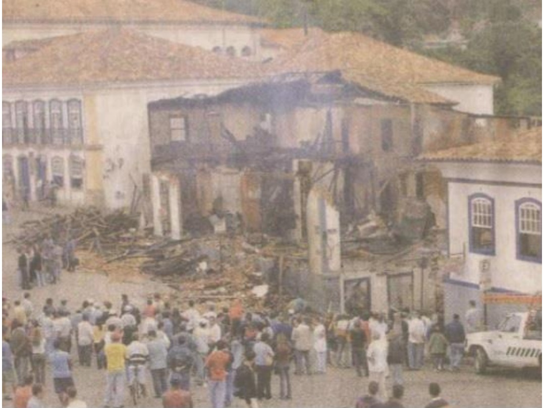
Figura 17: Ruínas do Hotel Pilão após o incêndio de 2003. Fonte: Eduardo Trópia. Jornal Estado de Minas (Capa), 15 de abril, 2003. Fonte: SILVA, 2011.
