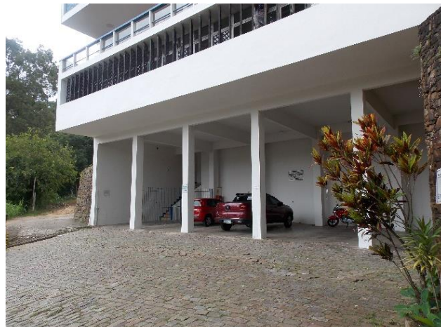
Figura 47 - Detalhe do estacionamento coberto, Grande Hotel.
