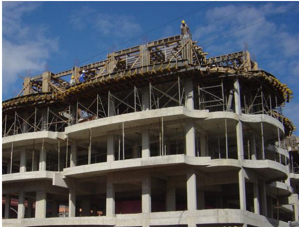
Figura 22 - Estruturas de Concreto Armado.
