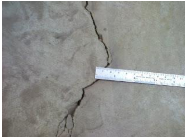
Figura 26 - Detalhe de Fissura em Concreto.
