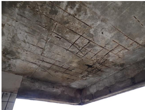
Figura 28 - Corrosão em laje de concreto com estrutura em barras de aço.
