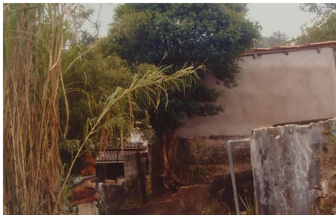
Figura 120 - Local onde ficava instalada caixa d'água após ser retirada. Grande Hotel, OP.
