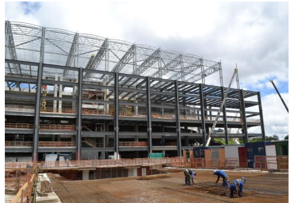
Figura 23 - Construção em concreto armado. Arena dos Paranaenses.
