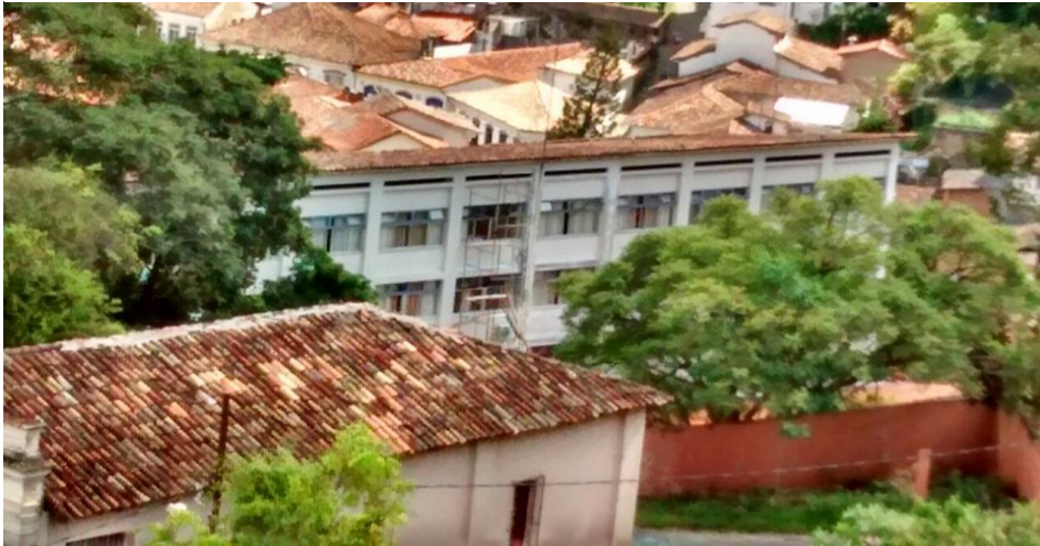
Figura 55 - Fachada Posterior. Grande Hotel, OP.
