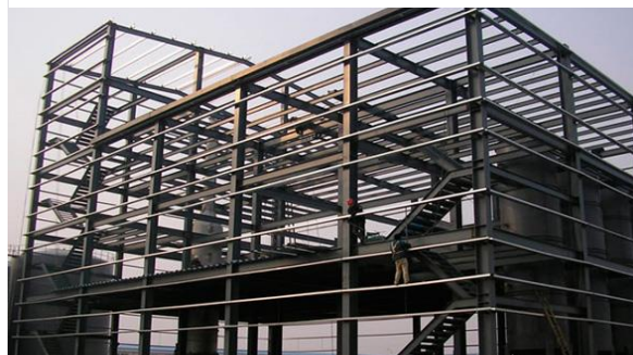
Figura 19 - Estrutura de aço em construção civil.
