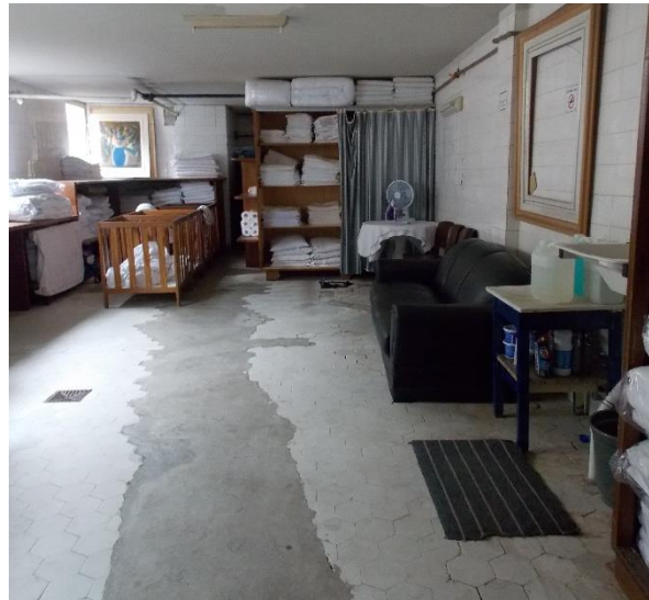
Figura 64 - Lavanderia. Grande Hotel, OP.
