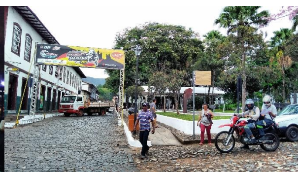
FIGURA 41 - Instalação da estrutura para o evento de Bike Enduro que aconteceu em abril de 2017
