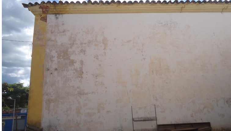
Figura 30 - Perda da camada pictórica Fonte: Dayana Sant'Ana Data: 2017
