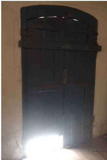
FIGURA 28 - Porta da sacristia quebrada
