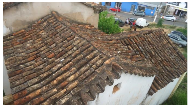
Figura 25 - Telhado (capela-mor e sacristia) Fonte: Wagner Barros Data: 2017
