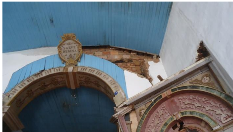
FIGURA 26 - Descolamento de parte da alvenaria
