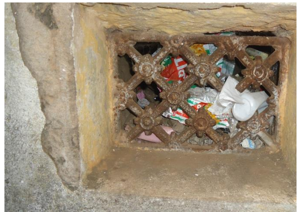
FIGURA 32 - Grelha de vedação da direita Fonte: Dayana Sant'Ana Data: 2017
