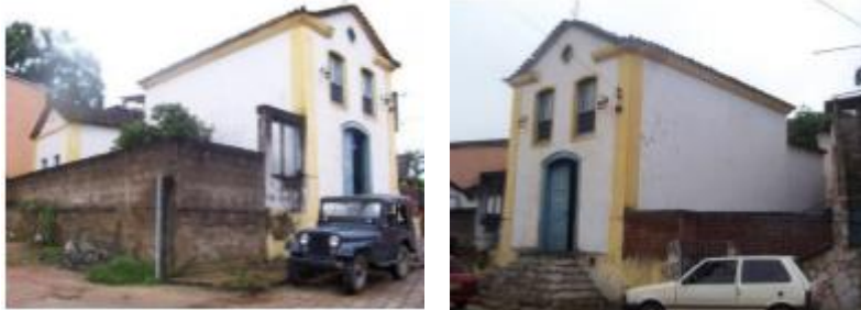
Vista frontal da Capela N.S. do Bom Despacho
