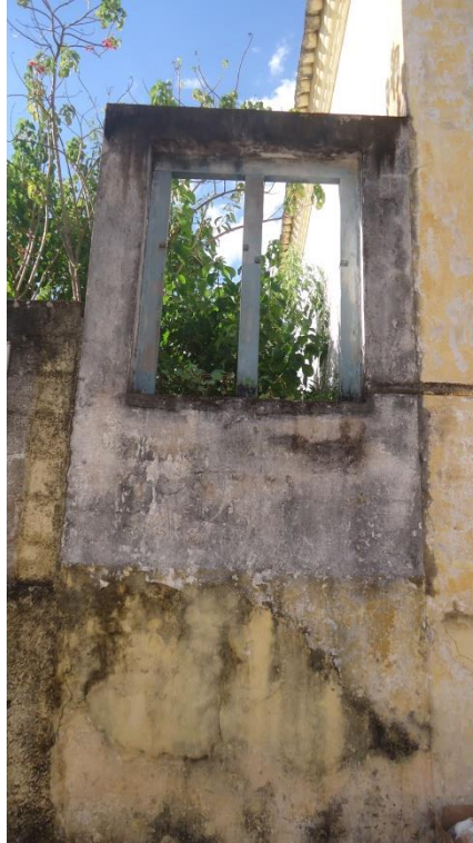
Figura 33 - Parede da sineira com sujidades
