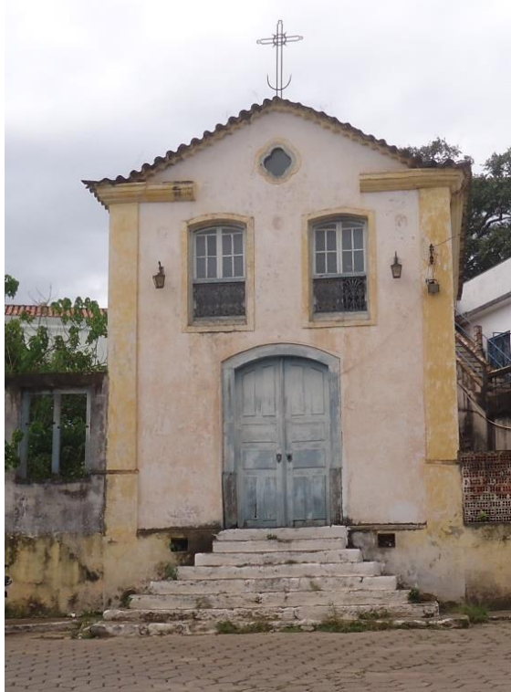
Figura 13: Fachada Frontal Fonte: Dayana Sant'Ana Data: 2017
