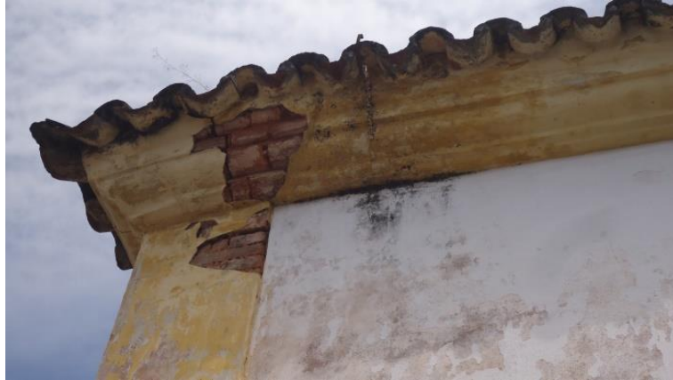
FIGURA 34 - Descolamento pontual do reboco Fonte: Dayana Sant'Ana Data: 2017
