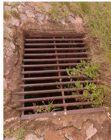
Figura 28: Bueiro Créditos Henrique Daher
