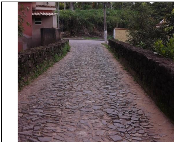
Figura 35: Ponte do Palácio, Cachoeira do Campo Fonte: Henrique Daher
