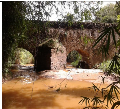
Figura 36: Ponte do Palácio, Cachoeira do Campo Fonte: Henrique Daher
