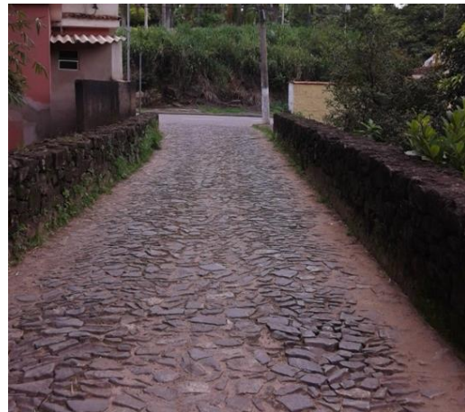
Figura 22: Ponte do Palácio Sentido Rua N.S. Auxiliadora/Br Fonte: Henrique Daher
