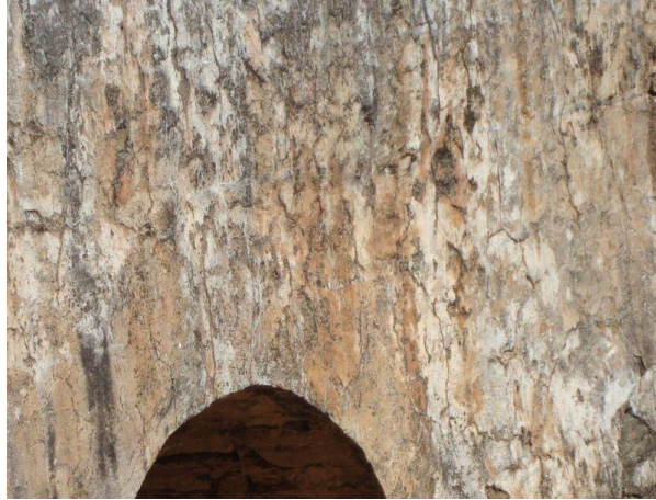
Figura 31: Muros de Tímpano Créditos: Wevertom Braz
