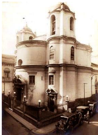
Figura 2: Igreja São Pedro dos Clérigos – RJ Fonte: https://coisasdaarquitectura.wordpress.com/2011/01/02/a-igreja-de-sao-pedro-dos-clerigos/
