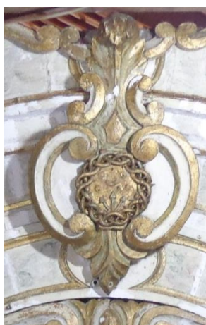
Figura 50: Detalhe da tarja Foto: Clara Ferreira - 24/11/2017
